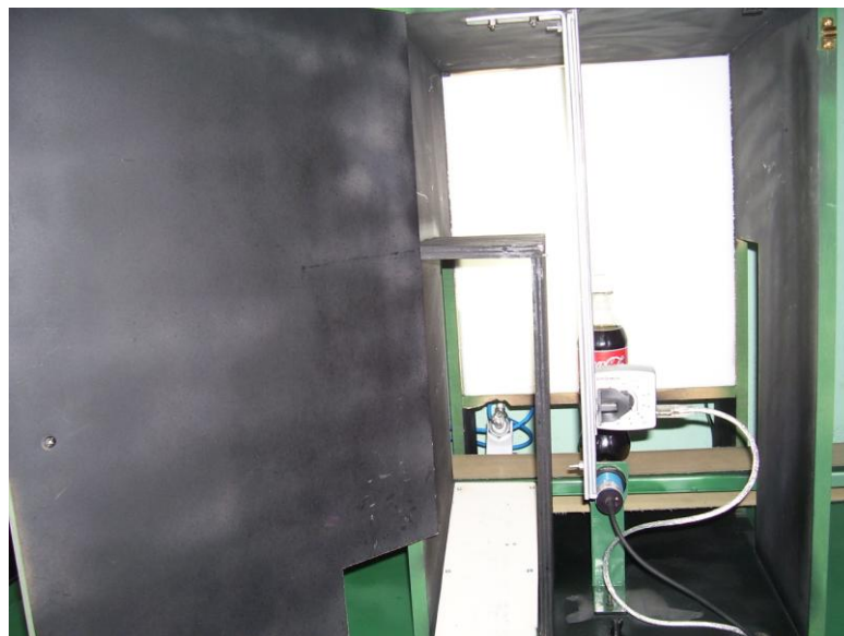
Figura 2.21. Interior del armario
