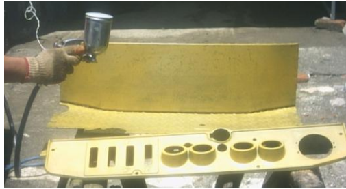
Fig. 6.13 Aplicación con pistola
