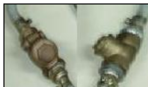
Figura 3.13. Válvulas check
