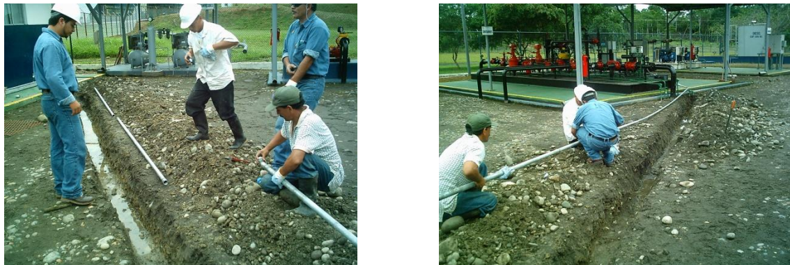
Figura 2.32 Instalación de conduit.
