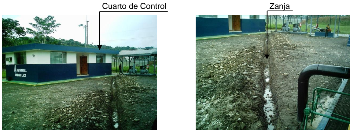
Figura 2.31. Excavación de la zanja.
