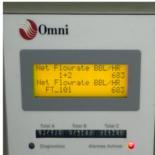
Figura 3.5. Monitoreo y registro del volumen transferido.
