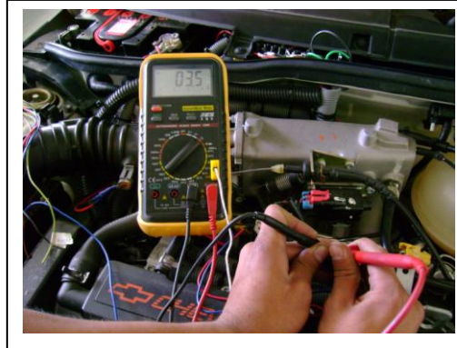
Figura 4.1 Comprobación de los sistemas eléctricos
