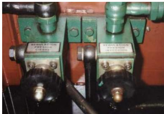
Reguladores de presión, del cierre apertura de molde, y de la unidad de inyección
