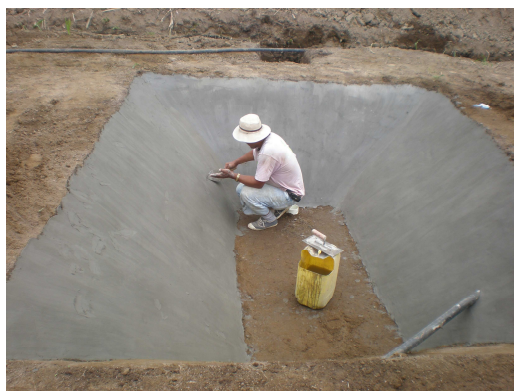
Foto 5. Aplicación del cemento en la piscina.
