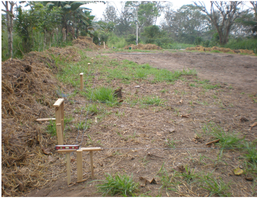
Foto 1. Nivelación del sitio del ensayo
