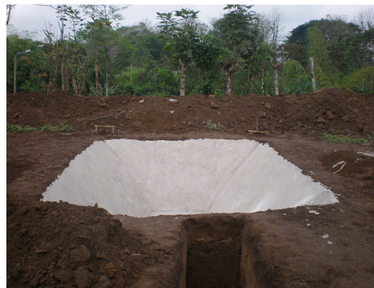
Foto 12. Piscina terminada con el revestimiento de argamasa.
