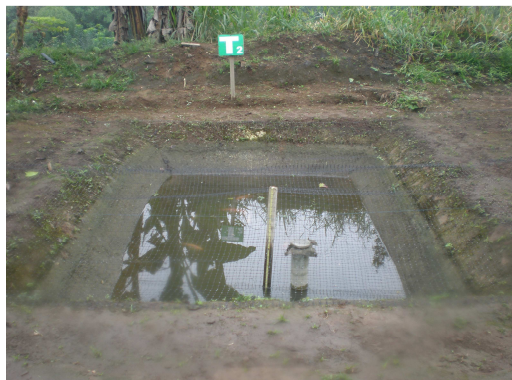
Foto 17. Piscina con bentonita
