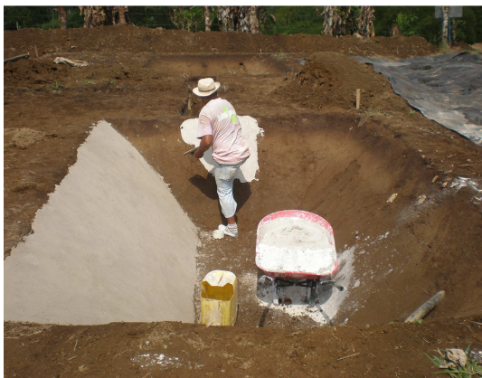
Foto 11. Aplicación del impermeabilizante de la argamasa
