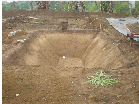
Foto 14. Piscina de tierra terminada.
