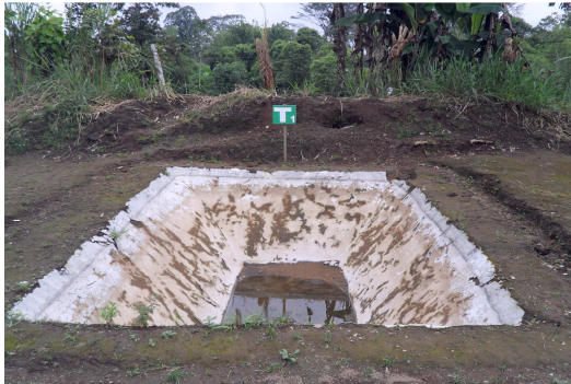
Foto 26. Piscina de cemento luego de 15 días de vaciado
