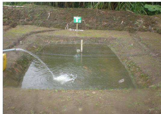
Foto 18. Reposición de agua a la piscina con bentonita
