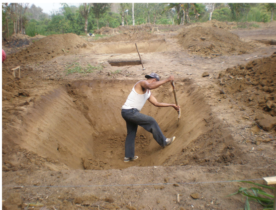
Foto 3. Peinado de los taludes
