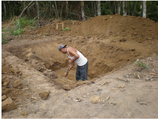
Foto 13. Construcción de la piscina de tierra.
