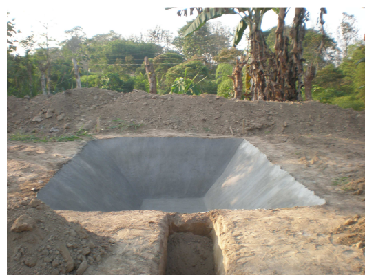
Foto 6. Piscina con revestimiento de cemento terminada.
