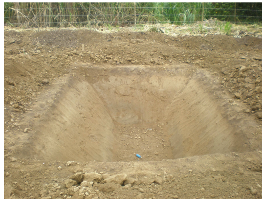
Foto 4. Piscina completamente terminada
