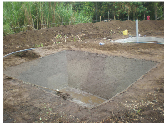
Foto 10. Piscina terminada con revestimiento de gley.
