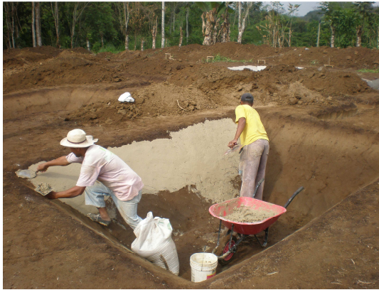
Foto 7. Aplicación de la bentonita
