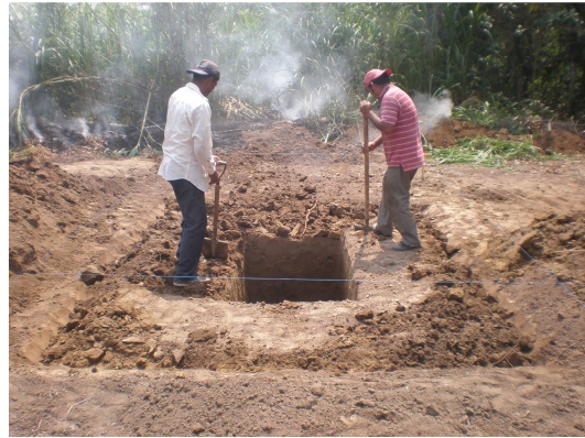
Foto 2. Excavación manual de las piscinas
