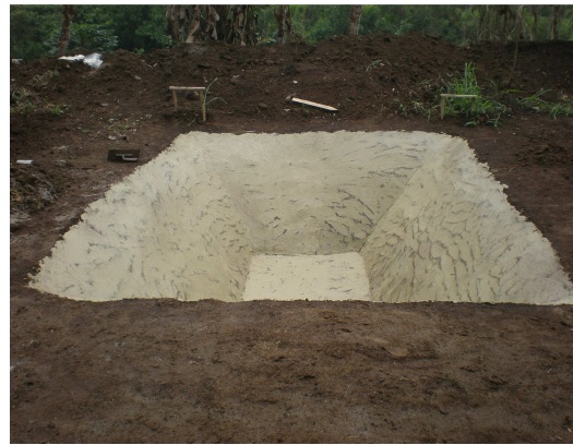
Foto 8. Piscina con revestimiento de bentonita terminada.
