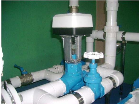
**Figura N° 4.9. Ubicación física del actuador lineal ML7420A3055
