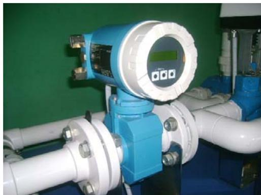
**Figura N° 4.8. Ubicación física del medidor de caudal electromagnético PROMAG.**
