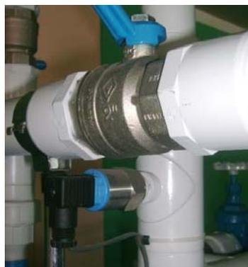
**Figura N° 4.6. Ubicación física transductor de presión de descarga Cerabar T PMC 131-A22F1Q4R.**
