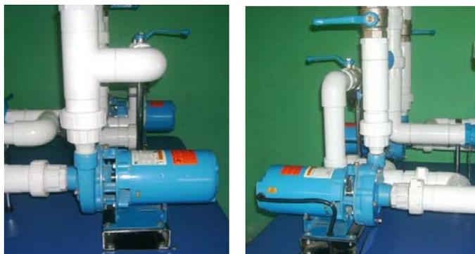
**Figura N° 4.2. Ubicación física de las bombas centrífugas GOULDS.**
