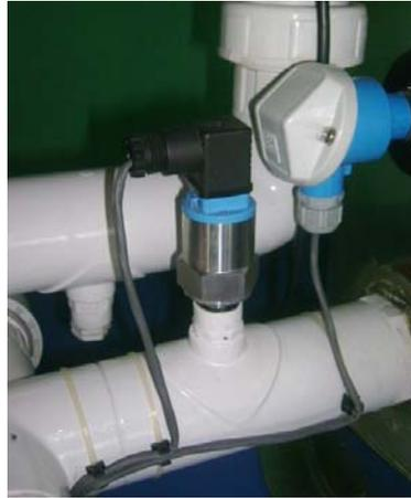
**Figura N° 4.7. Ubicación física transductor de presión de succión Cerabar T PMC 131-A22F1A3C.**
