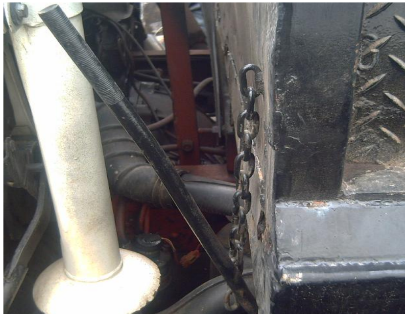
Figura 4.20 Palanca de apertura de la compuerta
