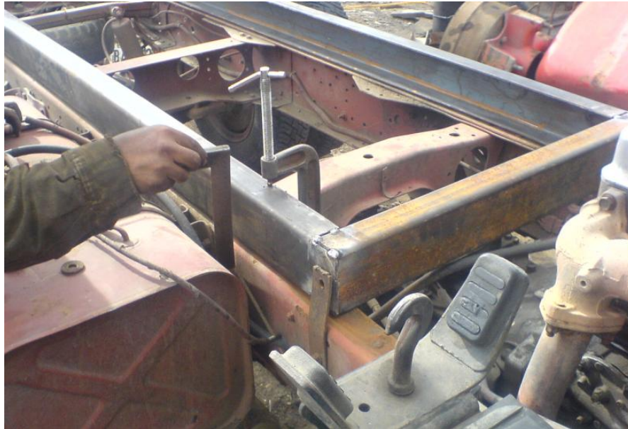
Figura 4.8 Alineación de la estructura soporte
