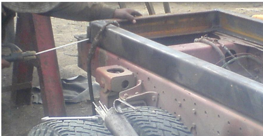
Figura 4.7 Soldadura de los perfiles estructurales
