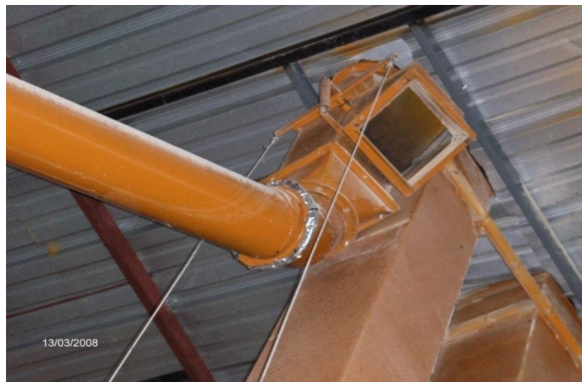
Figura 2.15 Selector de posición para Empaque o despacho de Producto al Granel
