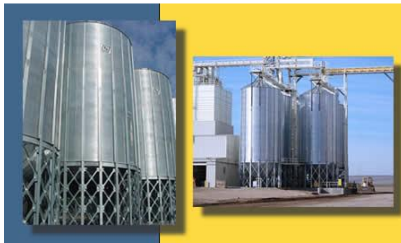
Figura 2.5 Silos de Almacenamiento con fondo Cónico
