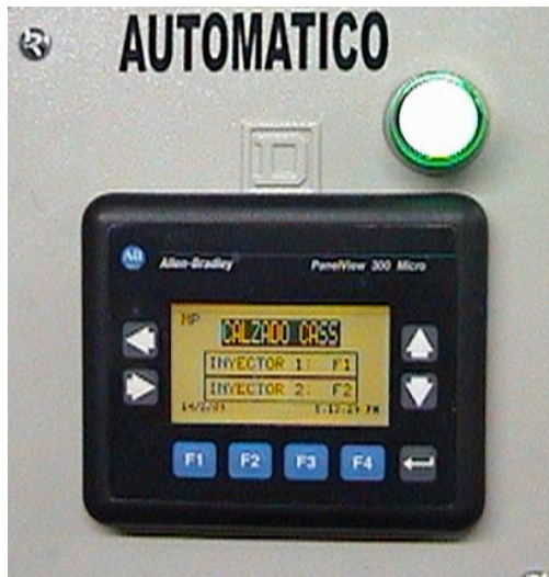
Figura 3.28. Montaje del Panel de operador.
