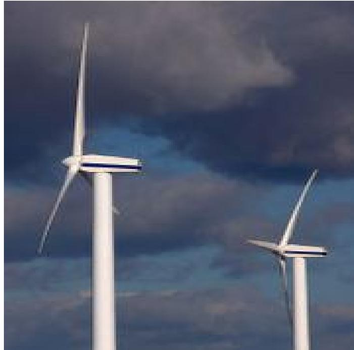
Figura 1.10.- Dos aerogeneradores de eje horizontal y tres palas.
