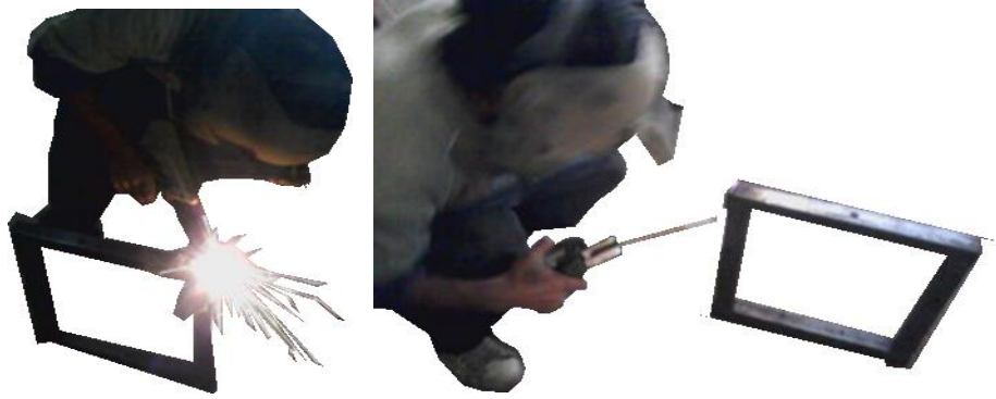
Figura. 3.57 Soldado De La Estructura
