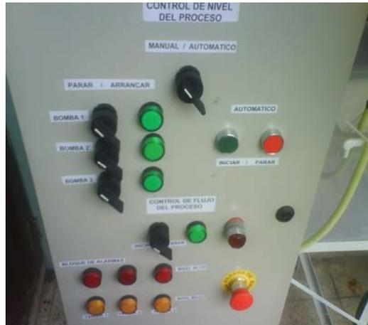
**Figura 7.4.** Panel de Control del Sistema para el Circuito de Reciclaje de Agua
