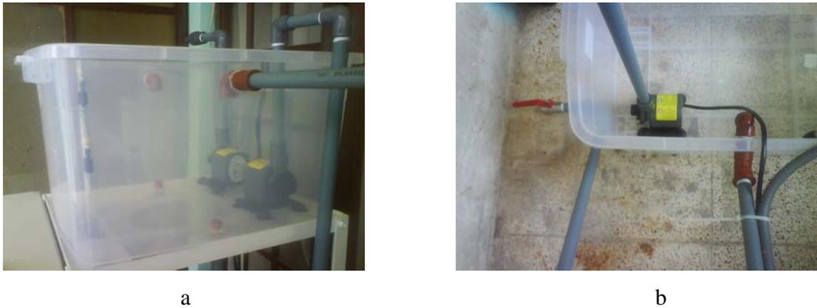
**Figura 7.2.** a) Interruptores de nivel y bombas para el control de nivel del sistema.
