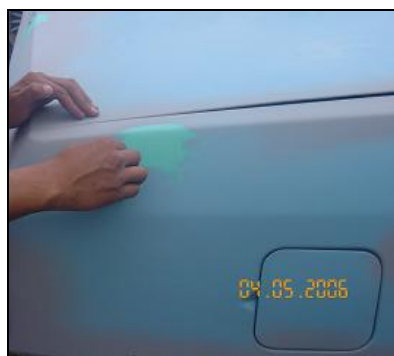
Figura 6.10 Masillado de la cajuela.
