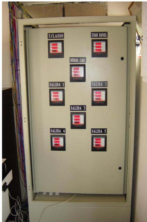
**Figura 5.2** Parte frontal del Armario de Control Subestación Mulaló.
