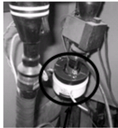
Inyección de Señal PLC en Media Tensión
