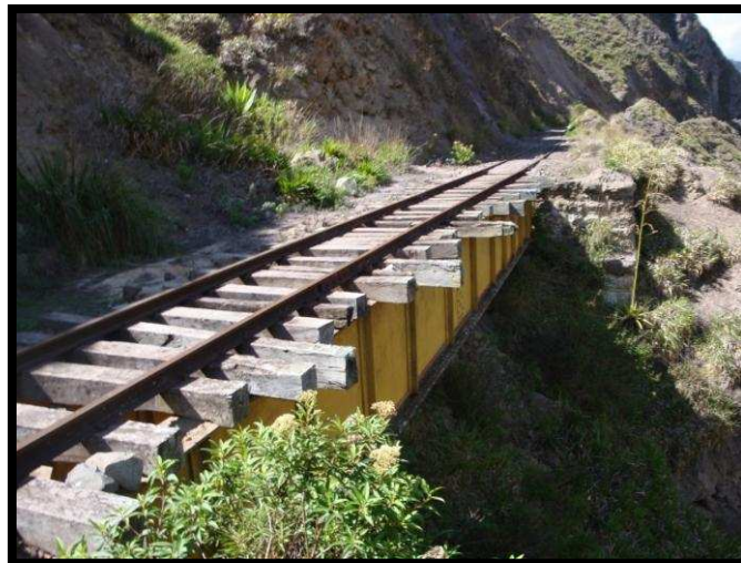
Figura 1. Puente ferroviario con vigas de alma llena y tablero superior ubicado en el tramo Sibambe Alausí.
