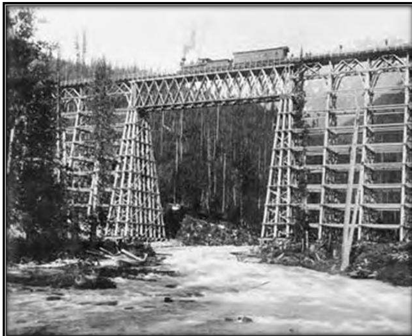
Figura 1.23. Palizada y celosía tipo Howe en el Canadian Pacific Railway (1885).
