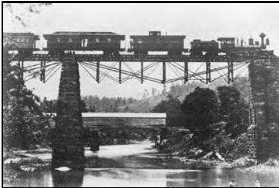
Figura 1.35 Locomotora sobre celosía Tipo Fink.
