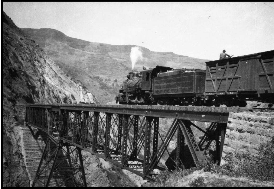
Figura 1.10 Locomotora sobre puente ferroviario tipo cercha.
