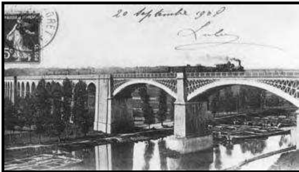
Figura 1.36. Viaducto de Saint-Mammes, sobre el río Loing en la línea Paris-Dijon
