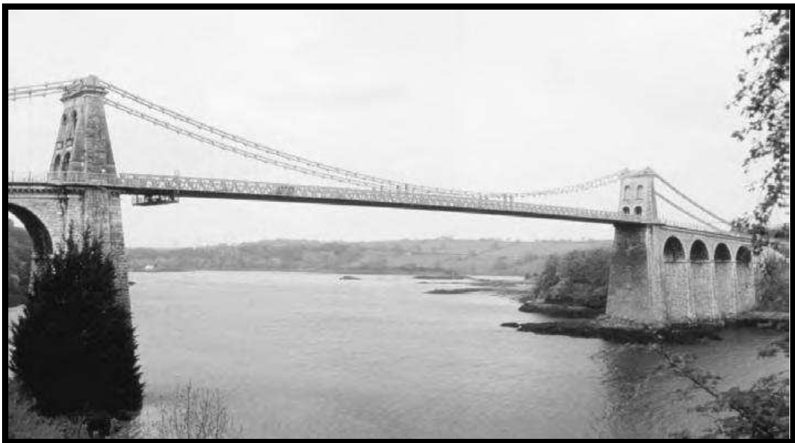
Figura 1.26. Puente colgante de Telford sobre el estrecho de Menai, con una luz de 177 metros, entre Gales y la isla de Anglesey (1826).
