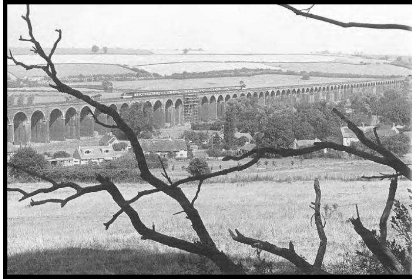
Figura 1.20 Haringworth Viaduct, uno de los más largos viaductos de piedra del país, cruzando el río Welland (1879).
