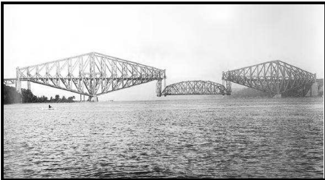
Figura 1.45. Vista de la elevación del tramo central del puente de Quebec durante su erección.
