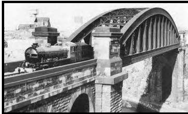
Figura 1.38. Arco bowstring de Mokwearmouth, sobre el río Wear (1879).
