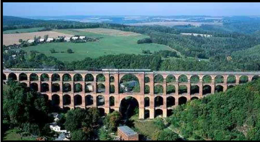
Figura 1.21. Viaducto de Goltzsch (1851), el mayor viaducto de piedra nunca construido.
