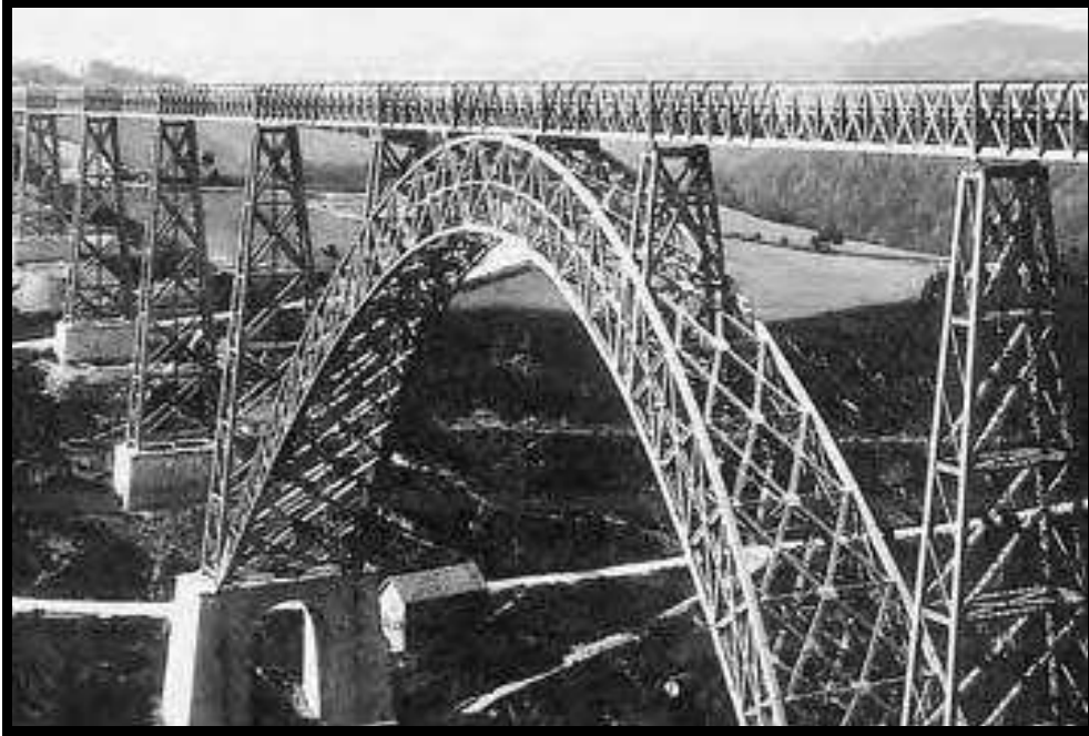
Figura 1.41. Viaducto de Garabit en el macizo central francés (línea Marvejols-Neussargues, 1884).
