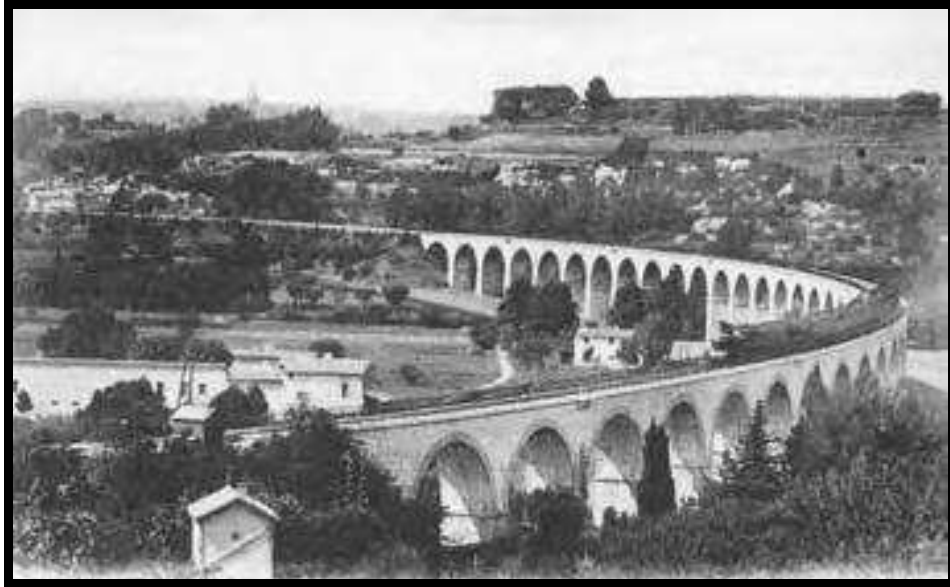
Figura 1.19. Viaducto de Aix-en-Provence, en la línea a Marsella.
