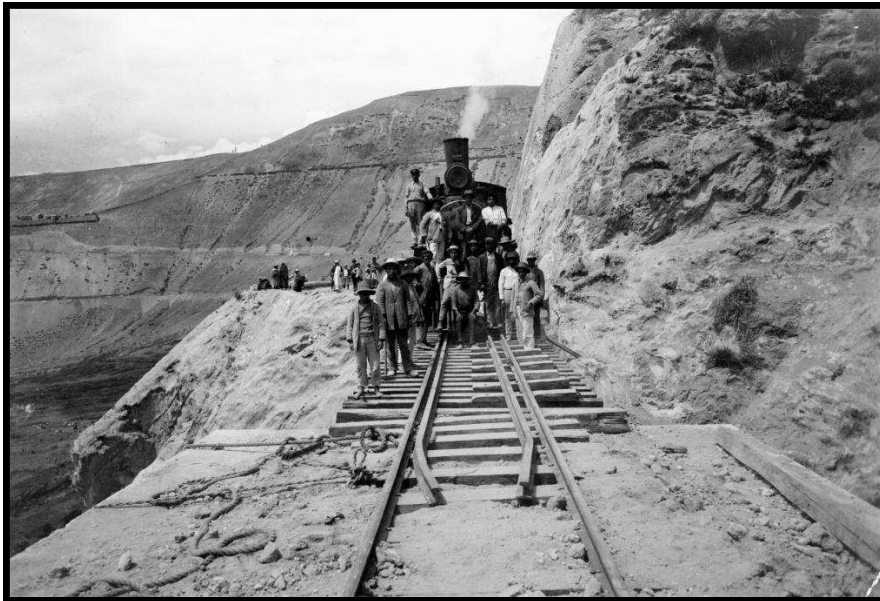
Figura1.1 Obreros junto a locomotora a vapor sobre puente férreo en el tramo Alausí-Riobamba.
