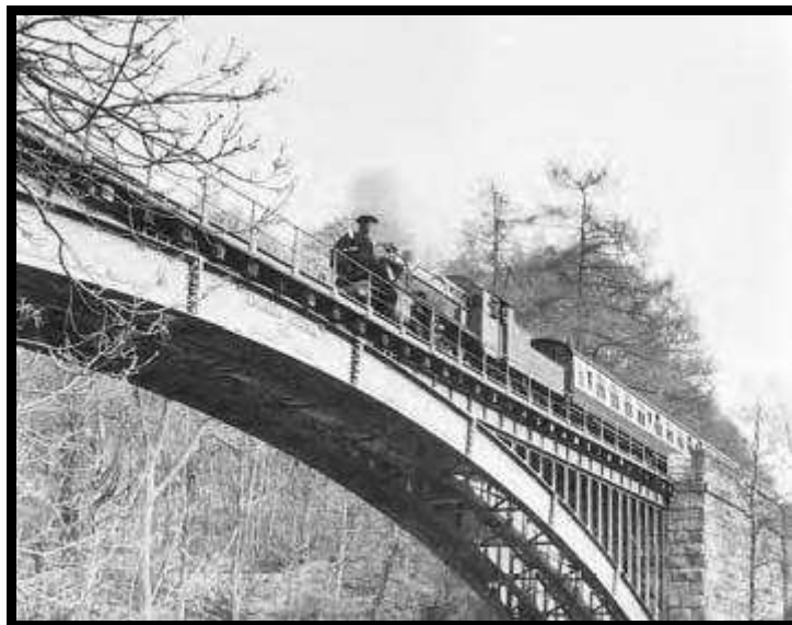
Figura 1.37. Viaducto británico de Victoria (Arley-Worcester, 1862), Waterside (Ingleton-Tebay, 1861)
