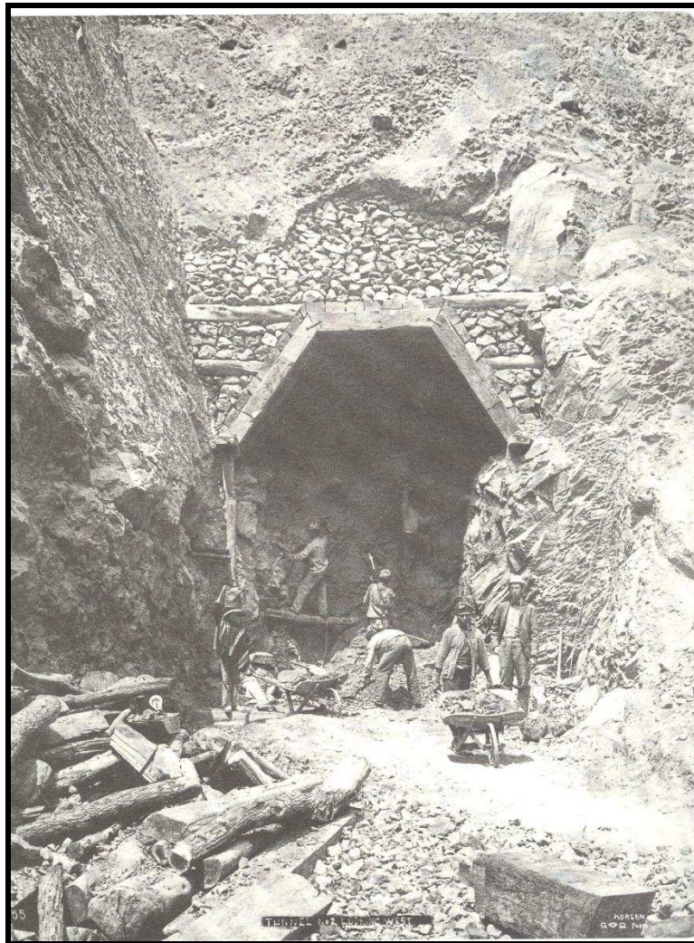
Figura1.5 fotografía del Túnel Nro. 2 en el tramo Huigra Sibambe.
