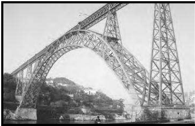
Figura 1.40. El puente de María Pía sobre el Duero (Oporto,1877).
