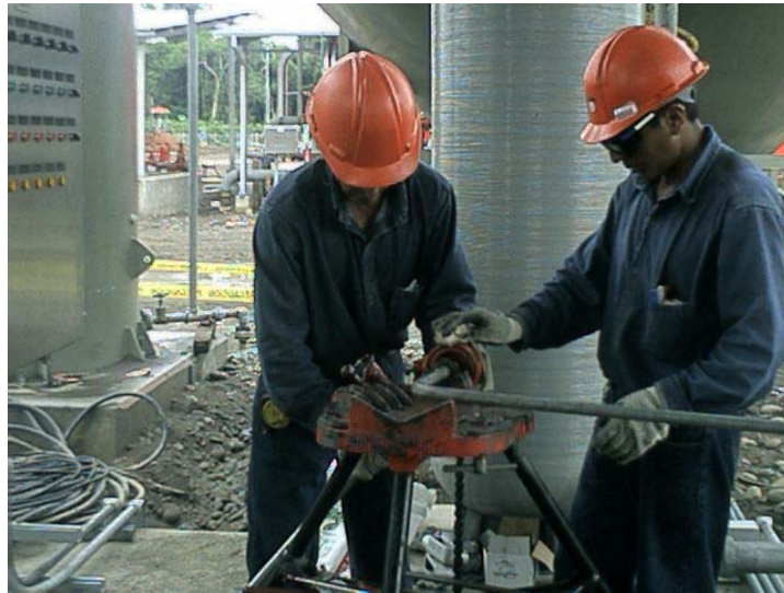
Figura 4. 24 Dobladora de tubería conduit
