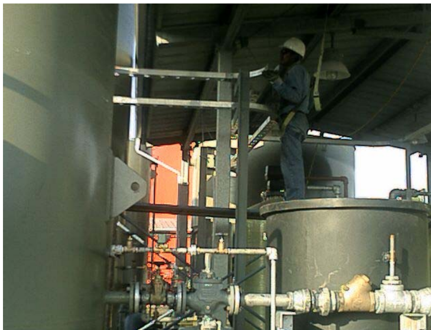
Figura 4. 23 Instalación de curvas horizontales
