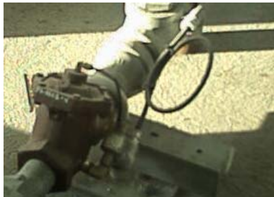
Figura 4.47 Conexiones Válvula solenoide
