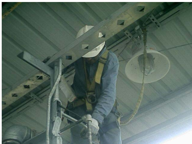
Figura 4. 28 Instalación de cable a través de bandeja y tubo conduit
