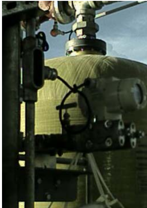
Figura 4. 39 Conexionado del transmisor de presión diferencial
