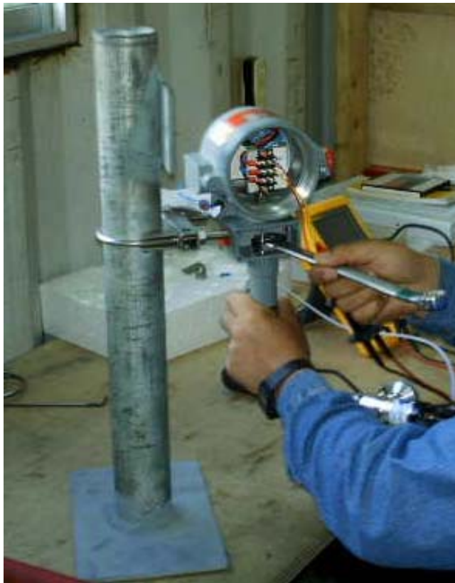
Figura 4. 17 Montaje de transmisores
