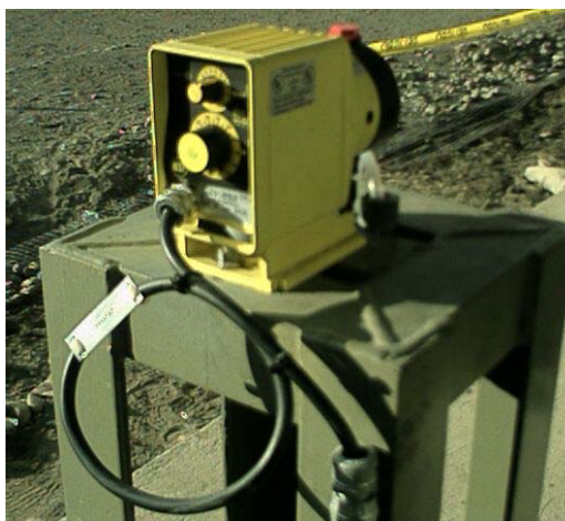
Figura 4. 29 Conexión del cable a la bomba dosificadora
