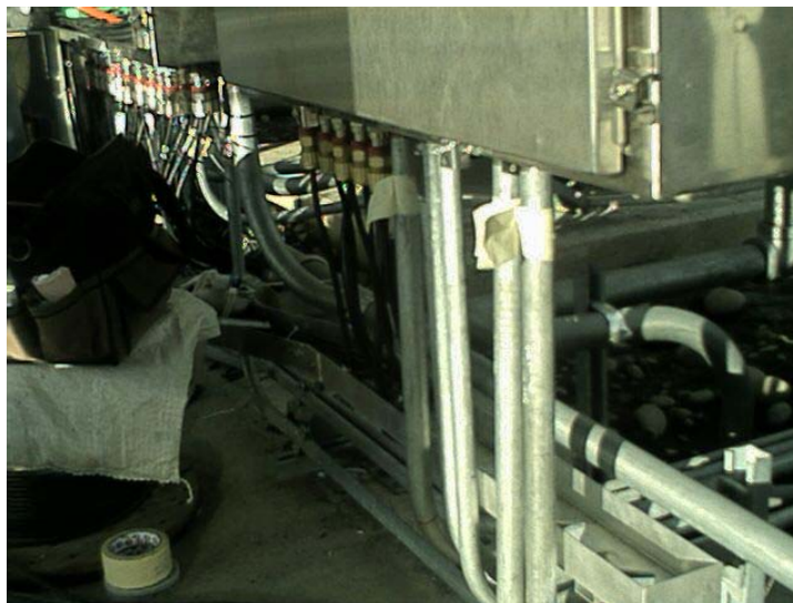
Figura 4. 25 Instalación de tubería conduit
