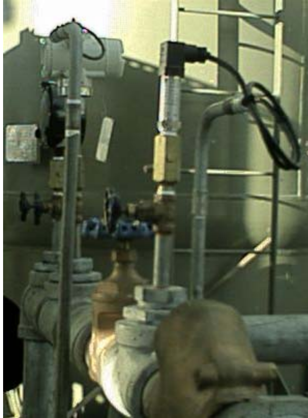
Figura 4. 40 Instalación del switch de presión
