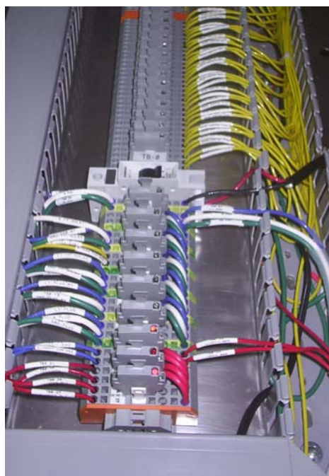
Figura 4. 7 Bloque de terminales TB0
