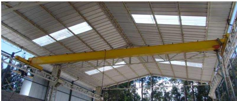
**Figura 2.13 Representación estructuras reticulares**
