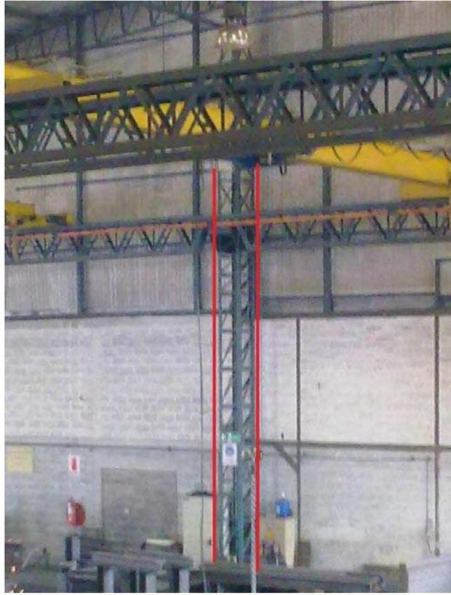
**Figura 5.7. Imagen de verificación deformación de columna**
