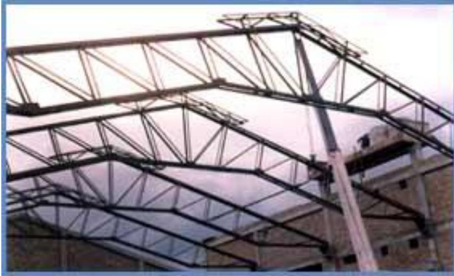
**Figura 2.7 Pórtico Metálico de miembros armados**
