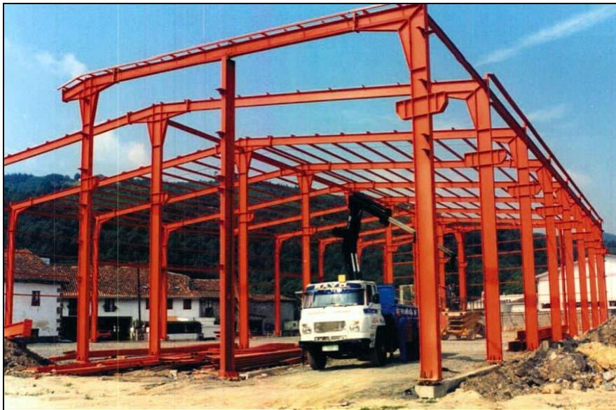
**Figura 2.6 Pórtico Metálico de alma llena**
