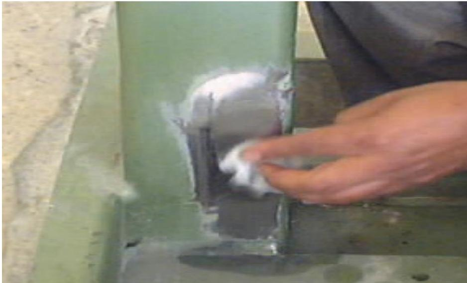
**Figura 3.67 Colocación del acondicionador.**
