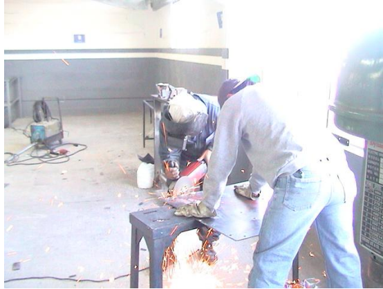
Figura 5. 2 Trabajos de corte y soldadura en estructura
