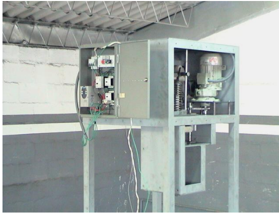
Figura 5. 9 Sistema de enrollado terminado
