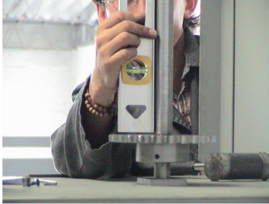
Figura 5. 8 Montaje de ejes en estructura soporte
