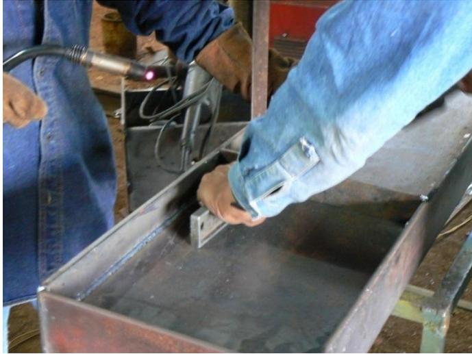
La figura 5.8 muestra como se suelda los rigidizadores en la viga.
