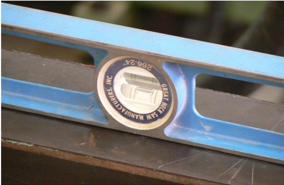
La figura 5.18 muestra la correcta alineación de la viga respecto a la horizontal.
