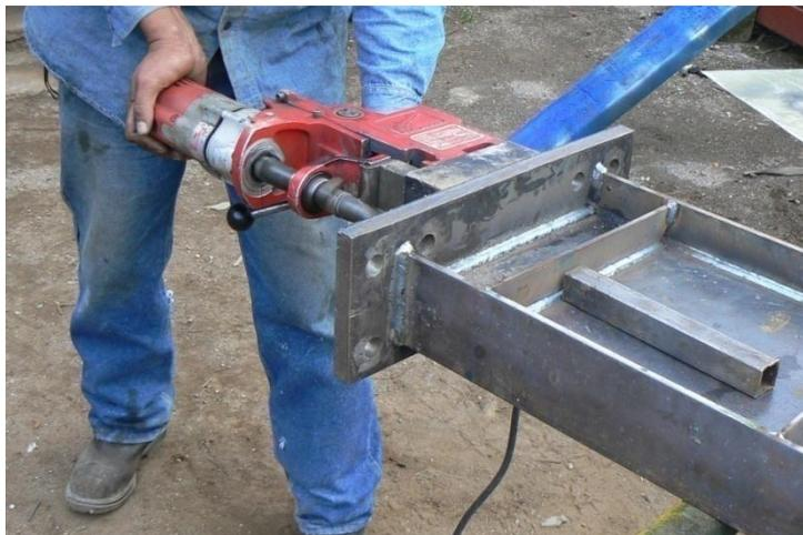
La figura 5.13 muestra el procedimiento de ajuste de los pernos en la conexión a 450 lb-pie, de acuerdo a las tablas del fabricante de pernos basada en el AISC.
