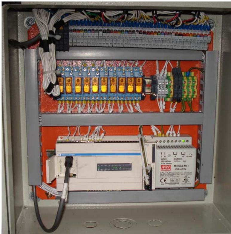
Figura 5.16. Montaje final del tablero de control U2.0
