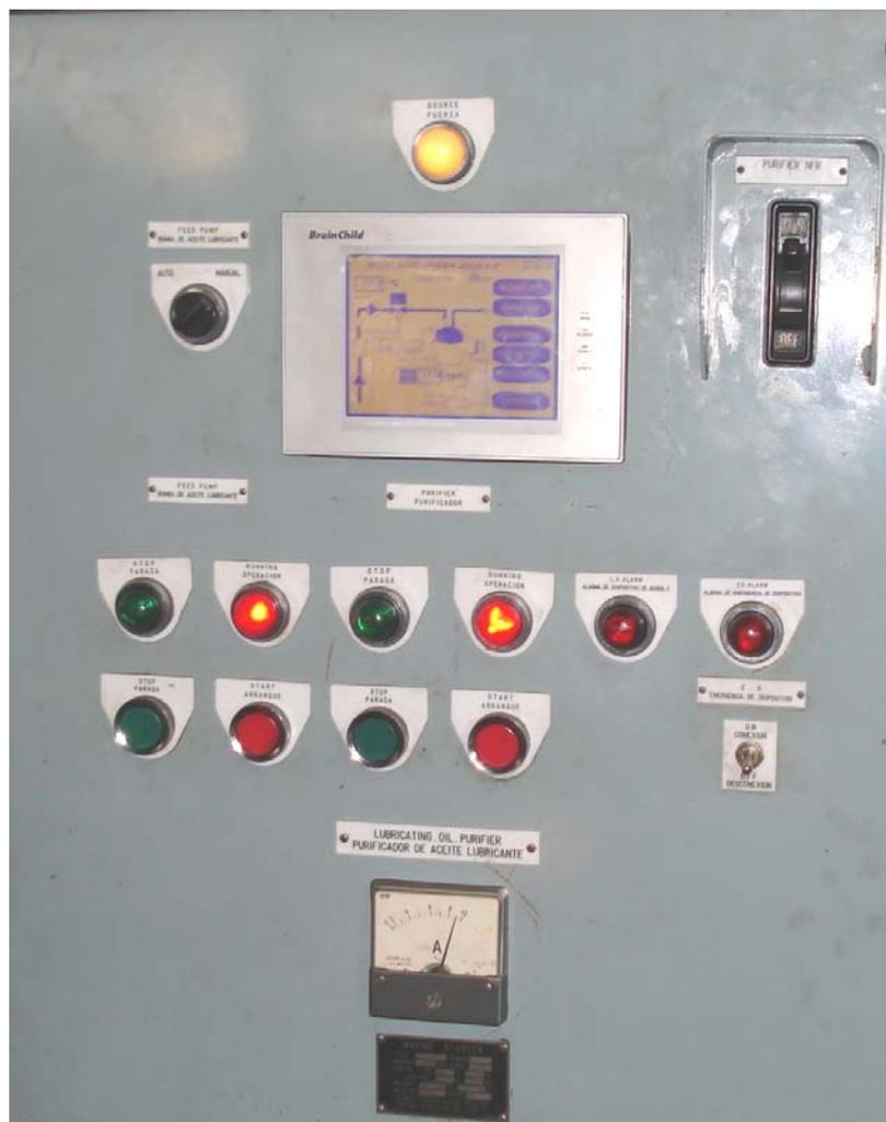
Figura 5.17. Montaje Final de la Interfase HMI
