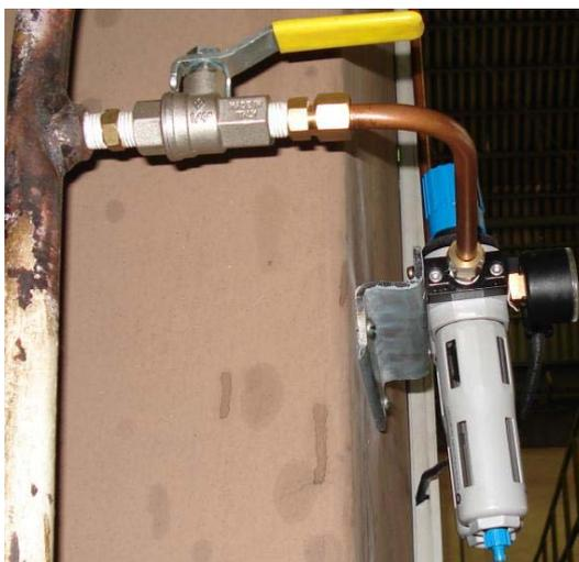
Figura 5.1. Montaje de Válvula de Paso
