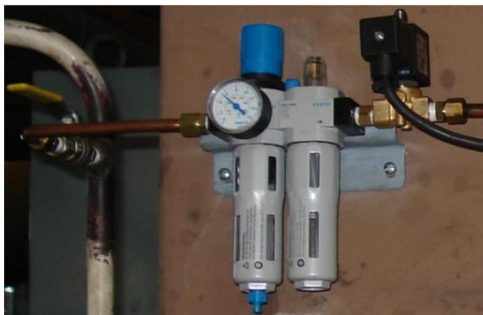
**Figura 5.2. Montaje de unidad de mantenimiento y válvula de control de Aire**
