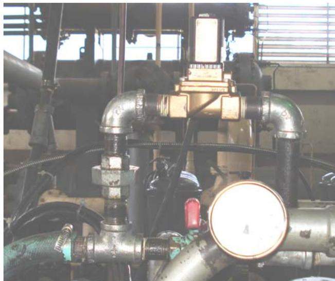
**Figura 5.9. Montaje final de la válvula de llenado y desplazamiento**
