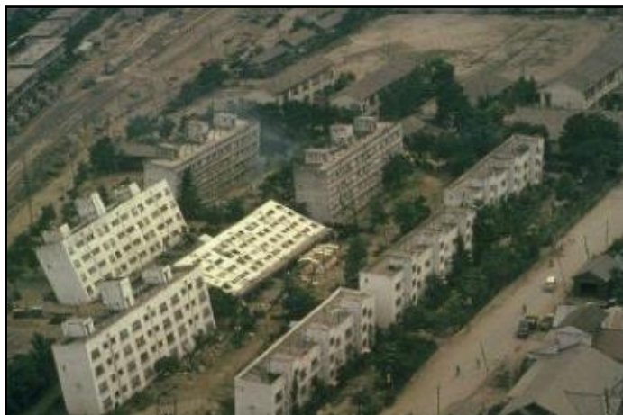
Figura 4.10: Licuefacción del suelo a causa del terremoto ocurrido en Niigata, Japón en 1964 (scribd.com)
