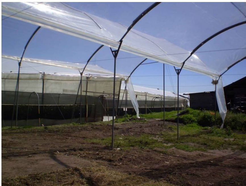
Figura 16. Área destinada para elaboración de compostaje.
