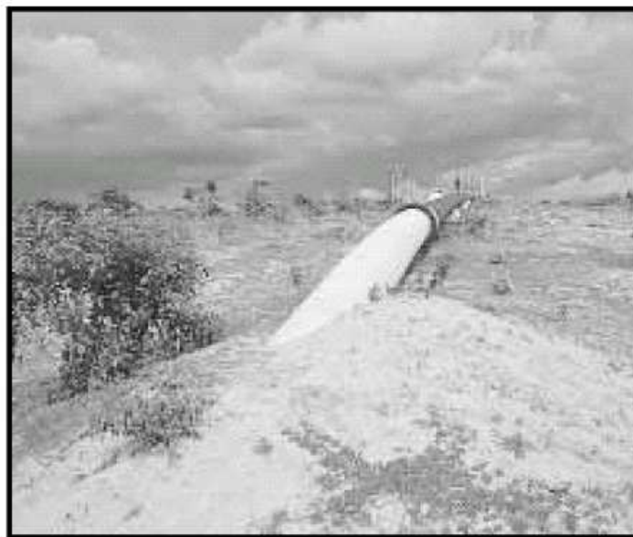
Figura 2.3 Tendido de Oleoducto Superficial y Subterráneo
