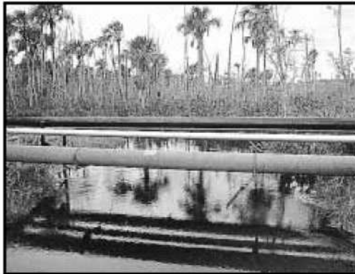
Figura 2.4 Tendido de Oleoducto sobre Soportes
