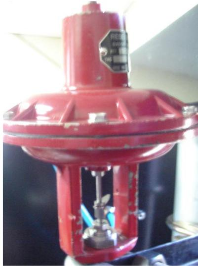
**Figura. 3.7. Actuador de Presión utilizado en el sistema**
