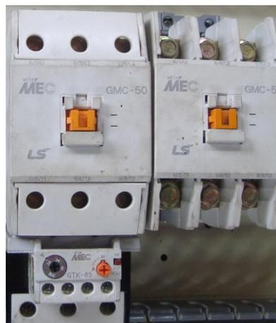
Figura 3.20: Contactores y relé térmico del circuito de fuerza
