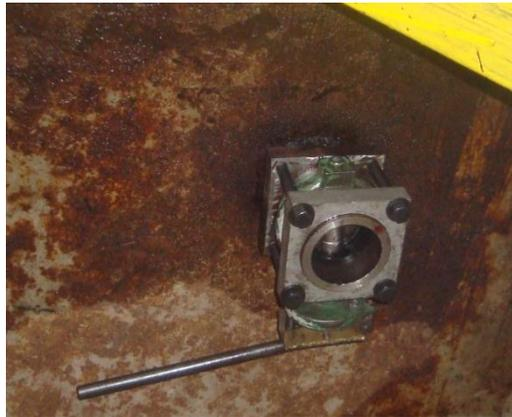
Figura 4.7: Montaje de la válvula de mariposa en el tanque principal de aceite
