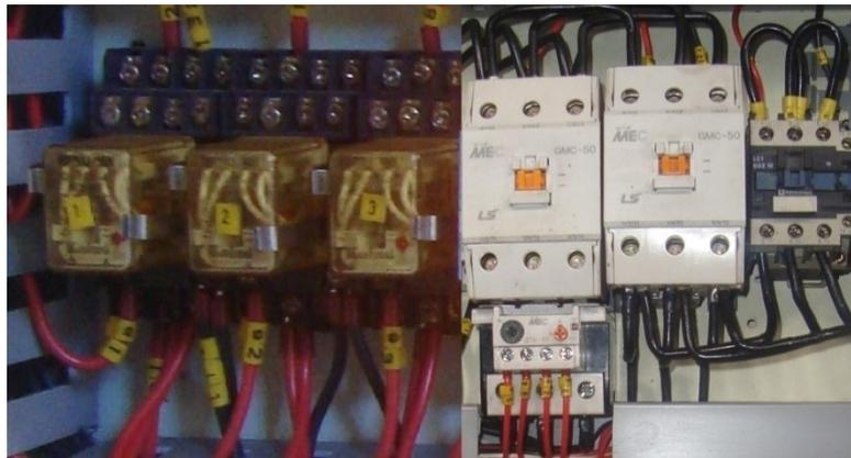
Figura 5.15: Activación de las bobinas de los contactores del motor
