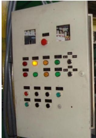
Figura 5.16: Luces de señalización en el tablero de control
