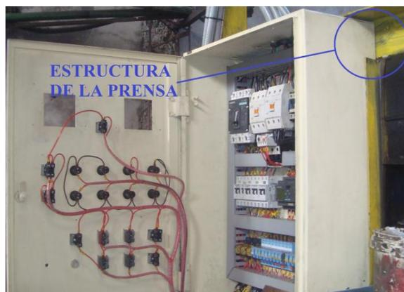
Figura 4.36: Tablero de control sujeto a la estructura de la prensa
