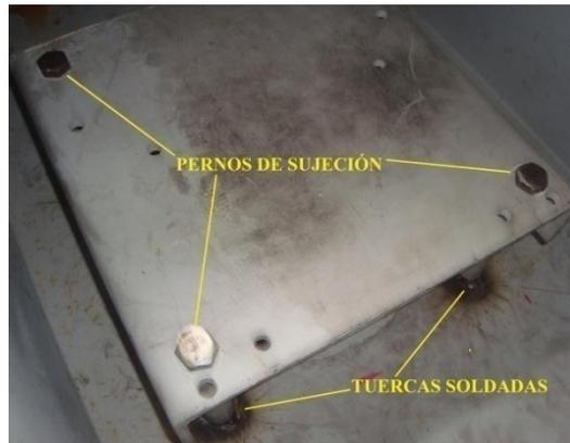
Figura 4.3: Capaceta montada en el interior del tanque
