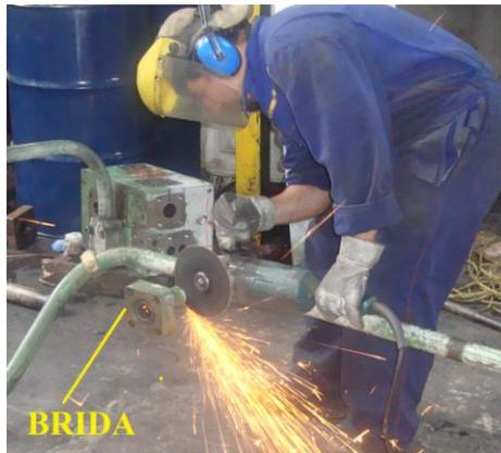
Figura 4.15: Corte de tuberías con bridas para montaje en el bloque
