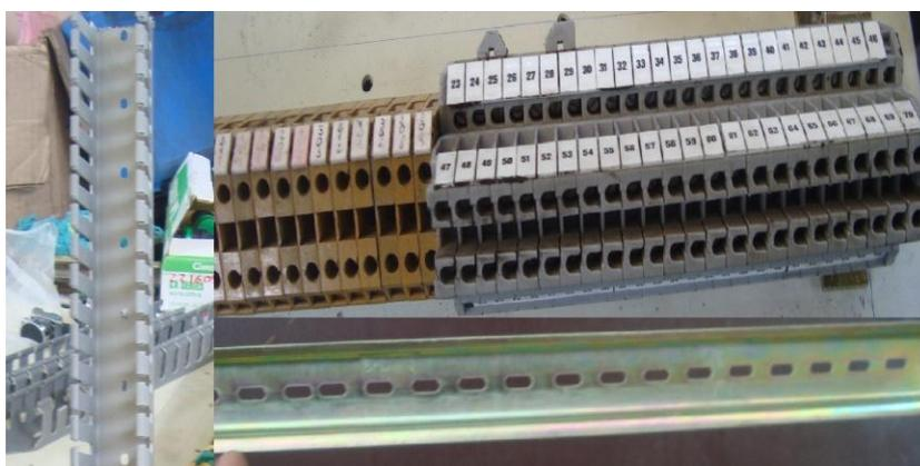
Figura 3.24: Canaleta, borneras y riel DIN
