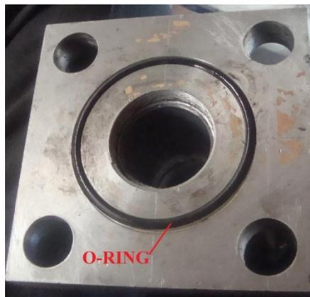
Figura 4.26: O-ring de la brida para evitar fugas de aceite
