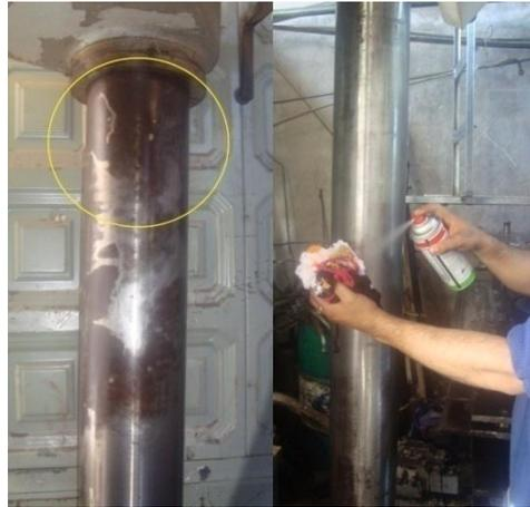
Figura 5.3: Izq: Columna con oxido, Der: Aplicación del limpiador en la columna
