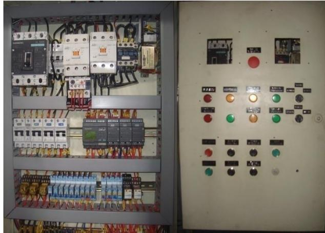
Figura 4.48: Tablero de control listo para controlar el funcionamiento de la prensa
