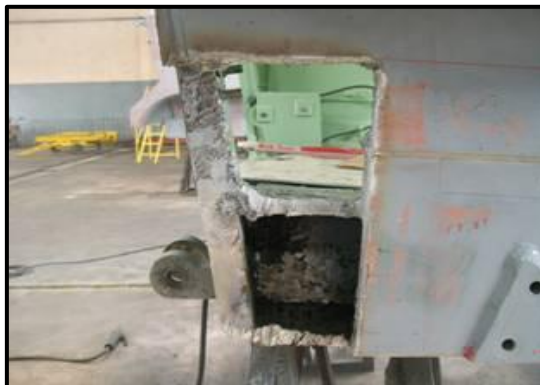
Figura. 3.76 Retiro de pedazo cortado
