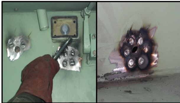
Figura. 3.116 Relleno de orificios interiores
