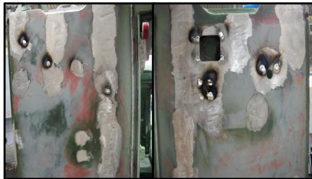
Figura. 3.115 Relleno de orificios exteriores
