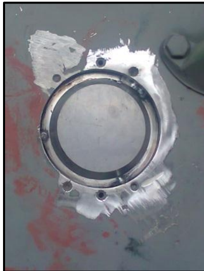
Figura. 3.103 Punteado de suelda
