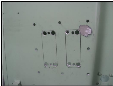
Figura. 3.19 Perforaciones dentro la marcación
