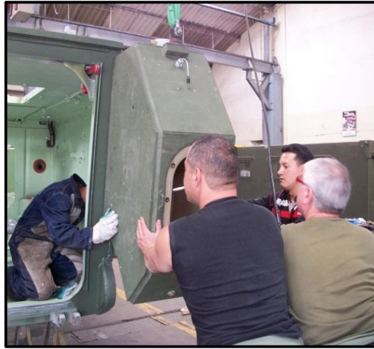
Figura. 3.126 Colocación de los depósitos de combustible
