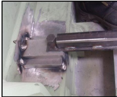
Figura. 3.10 Punteado de bases
