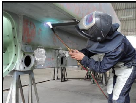
Figura. 3.98 Calentamiento de la zona y placa a soldar
