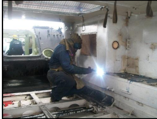
Figura. 3.107 Corte de depósito de combustible
