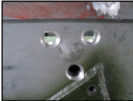
Figura. 3.28 Limpieza de Orificios
