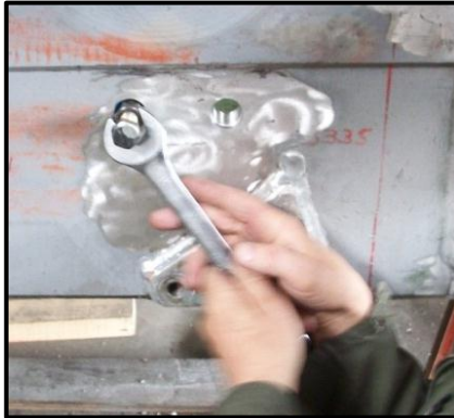
Figura. 3.60 Colocación de inserto
