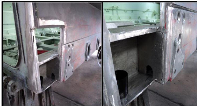
Figura. 3.79 Inspeccionar cortes de acuerdo al plano (anexo)
