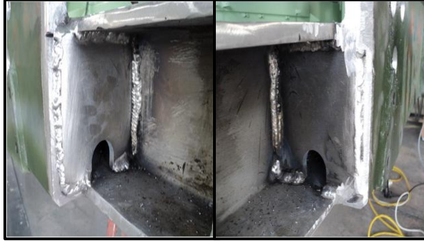
Figura. 3.80 Controlar cordones de suelda del refuerzo
