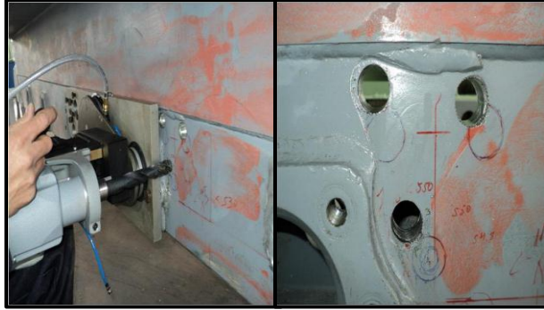
Figura. 3.24 Retiro de insertos
