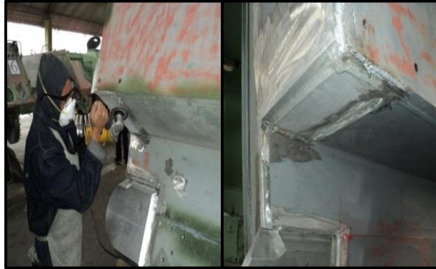
Figura. 3.111 Corte y pulido de rebordes
