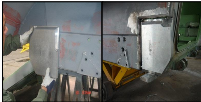
Figura. 3.81 Colocación y punteado de placa de rueda tensora
