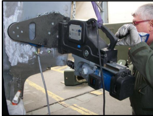
Figura. 3.122 Perforaciones inferiores de anclaje
