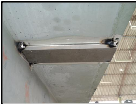
Figura. 3.97 Punteado de la placa
