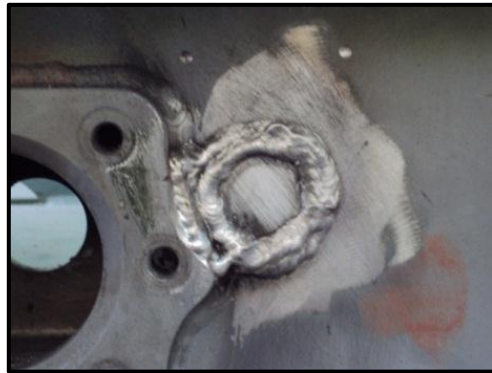
Figura. 3.46 Cordón de acabado
