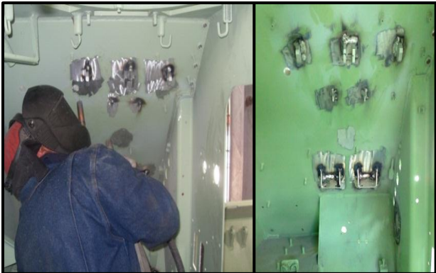
Figura. 3.70 Suelda del conjunto de bases del freno de pivoteo
