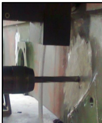
Figura. 3.51 Perforado con broca 12mm
