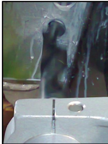
Figura. 3.88 Perforación con broca 32.50 mm
