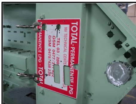
Figura. 3.17 Marcación de orificios
