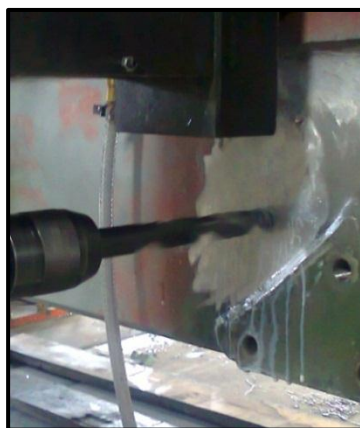
Figura. 3.52 Perforado con broca 20mm
