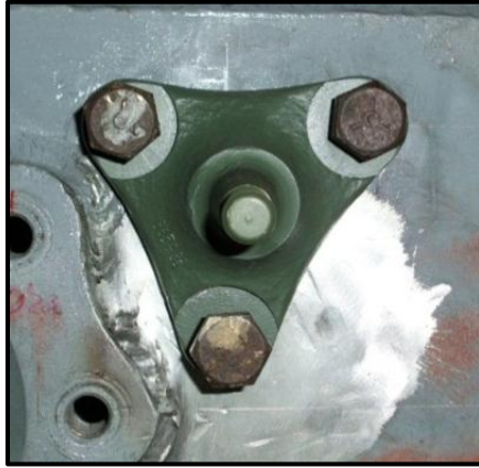
Figura. 3.63 Instalación de bases de suspensión
