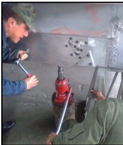
Figura. 3.48 Colocación de la matriz
