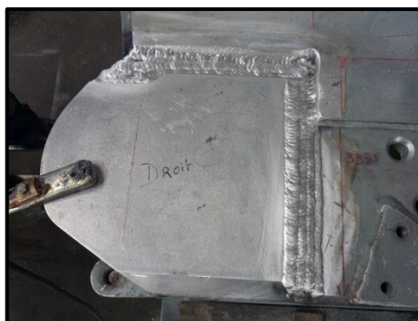
Figura. 3.82 Control de suelda
