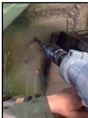
Figura. 3.86 Perforación con broca 14mm
