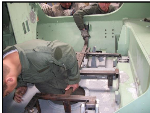
Figura. 3.8 Colocación del soporte guía
