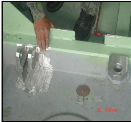
Figura. 3.9 Verificación de nuevas bases
