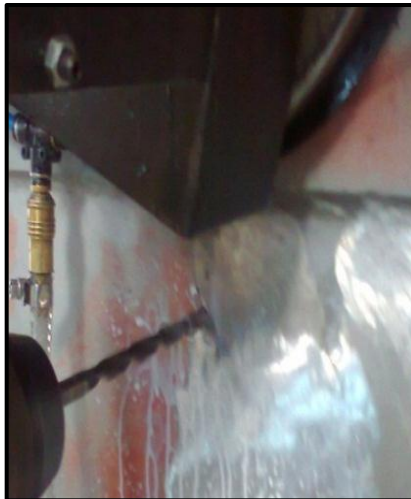
Figura. 3.50 Perforación con taladro magnético
