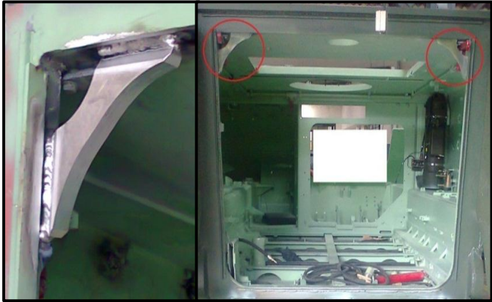
Figura. 3.128 Soldar los refuerzos
