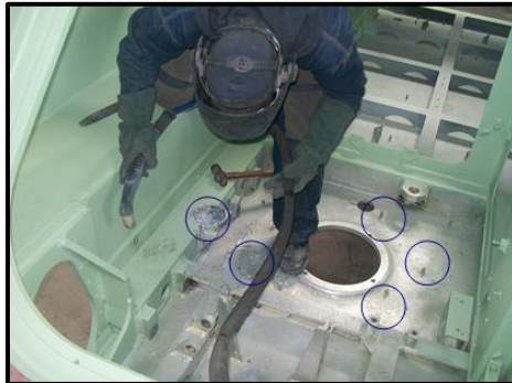
Figura.3.1 Identificación de las bases a cortar
