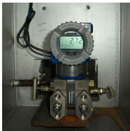
Figura 4-9 Presión de Trabajo del Horno de Fundición.
