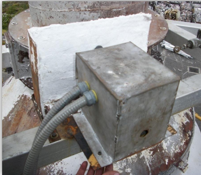
Figura 3-17 Montaje final del Motor Modutrol para controlar la posición del dámper Fuente CEDAL proceso de instalación
