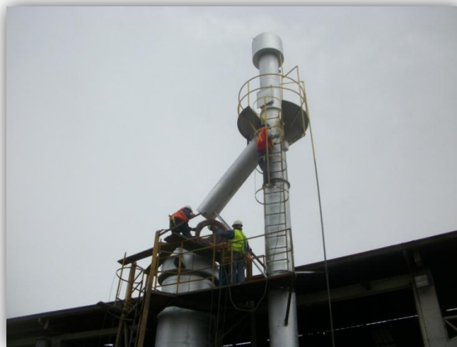
Figura 3-9 Sellando La Chimenea Fuente CEDAL proceso de instalación
