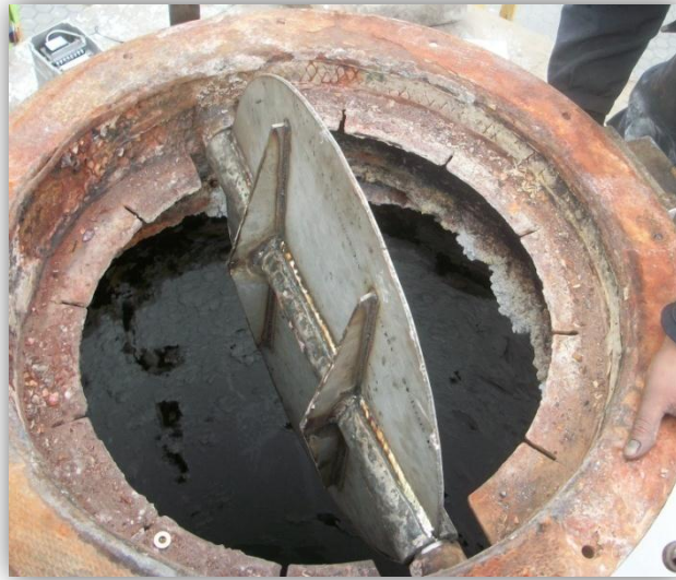
Figura 3-8 Dámper posición abierta Fuente CEDAL proceso de instalación
