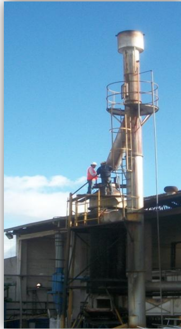
Figura 3-1 Supervisión de estado de la chimenea y evaluación del dámper antiguo.
