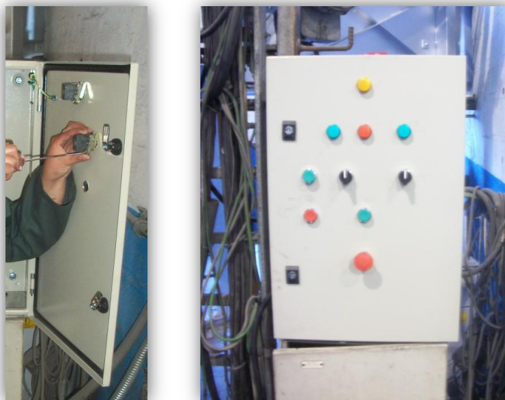
Figura 3-25 Ubicación de los pulsadores y luces indicadoras en el tablero de control
