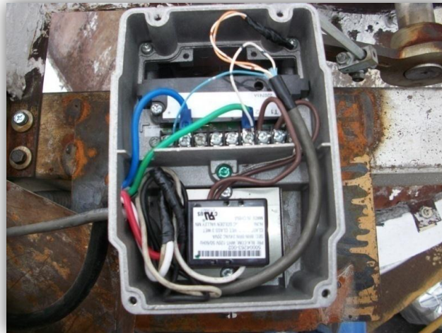
Figura 3-33 Conexiones eléctrica motor Modutrol
