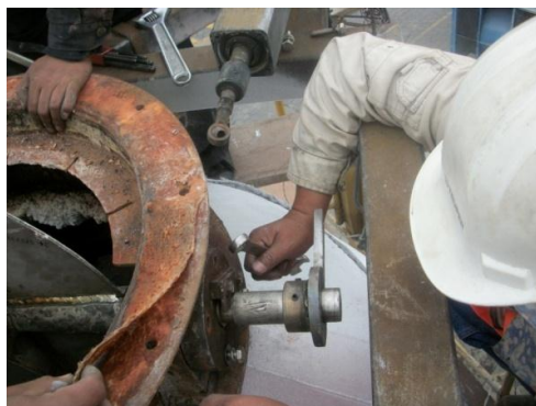
Figura 3-7 Ajuste de las bridas exteriores Fuente CEDAL proceso de instalación
