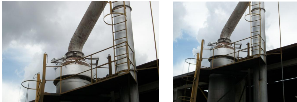
Figura 4-11 Dámara en funcionamiento
