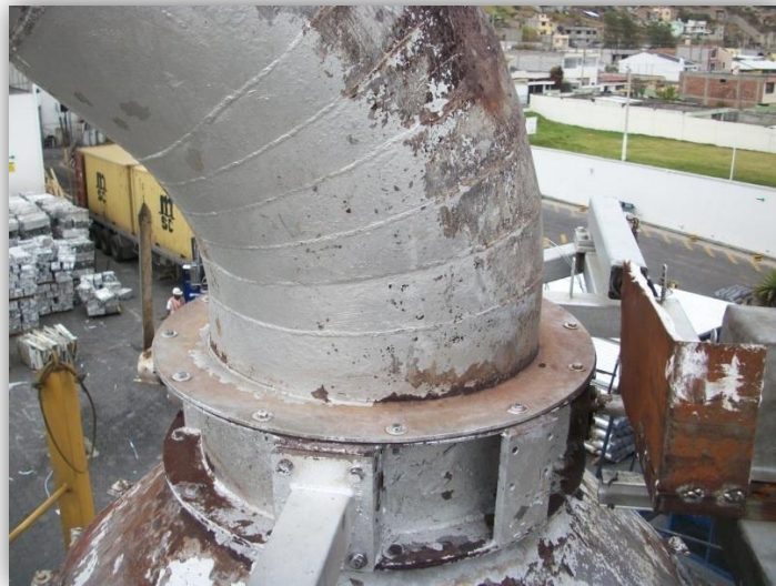
Figura 3-13 Colocación de la barrera de aislamiento de calor
