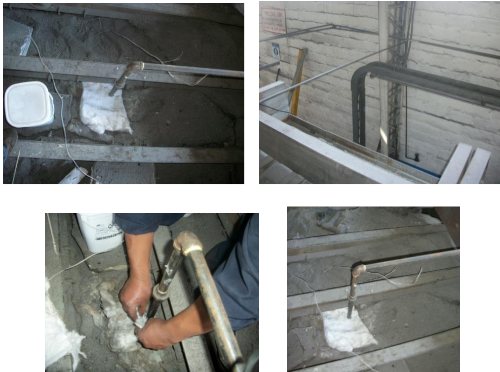
Figura 3-10 Instalación de la tubería para captar la presión del horno de fundición.
