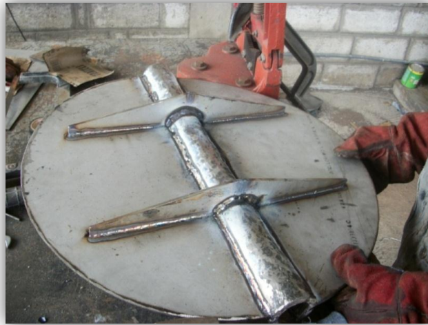
Figura 3-4 Construcción del Dámper
