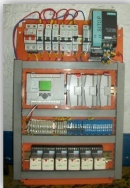
Figura 3-27 Colocación del PLC
