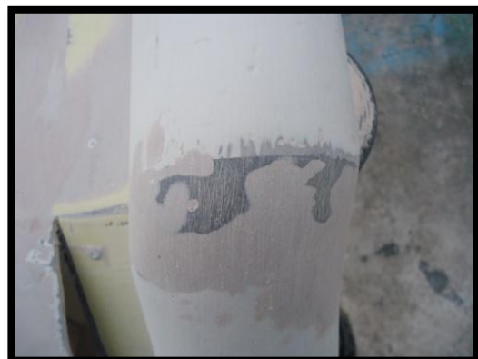
Figura 4.55 – Masilla en esquinas.
