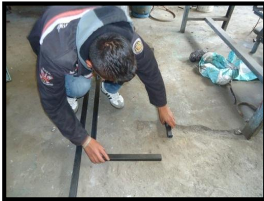
Figura 4. 20 – Verificación del material.
