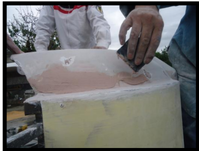
Figura 29 – Aplicación de masilla.
