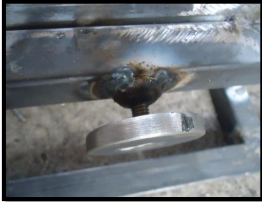
Figura 4. 40 – Soldadura de perilla.
