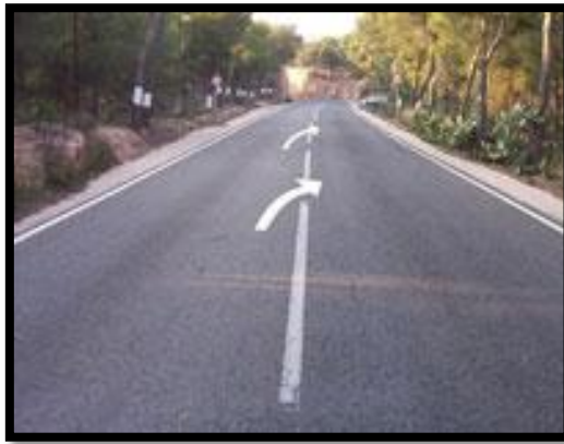
Figura 2. 12 – Marcas longitudinales en la carretera.
