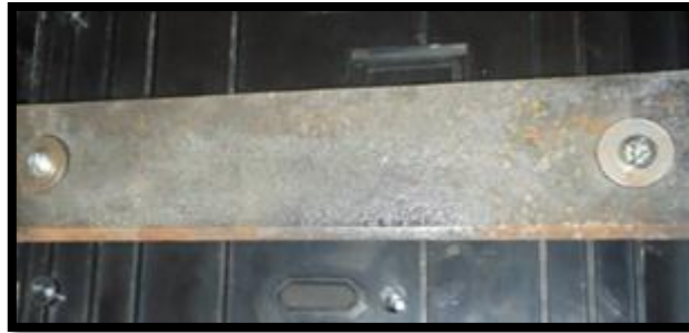
Figura 5. 11 – Pernos de sujeción.
