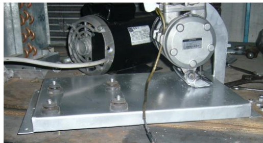
Figura 4.28 Colocación de los cauchos en la base metálica
