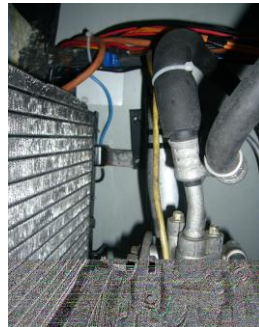
Figura 4.47 Conexión del compresor
