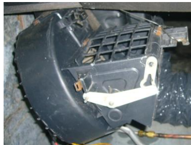
Figura 4.34 Colocación del ventilador del evaporador
