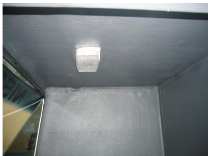
Figura 4.21 Corosil en el techo y las paredes laterales
