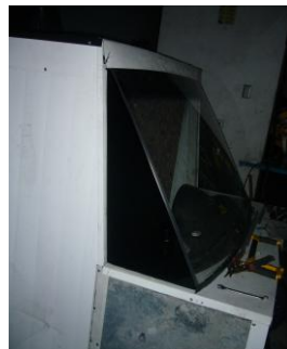
Figura 4.16 Colocación de los vidrios laterales
