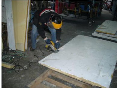
Figura 4.4 Cortando los paneles de poliuretano y poliestireno expandido
