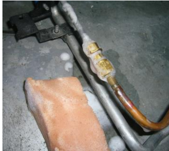
Figura 5.1 Prueba de fugas con solución jabonosa
