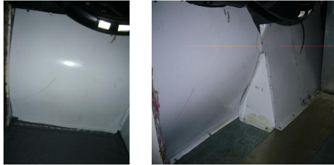
Figura 4.17 Colocación del metal debajo del tablero
