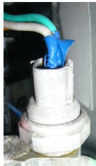
Figura 4.48 Conexión del presóstato de baja
