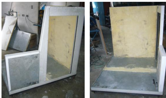
Figura 4.7 Colocación del panel lateral izquierdo
