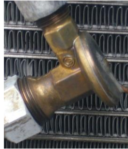
Figura 3.36 Válvula de expansión termostática
