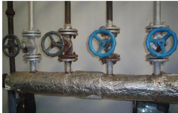
**Figura 4.8** Distribuidor de vapor del área de estampación
