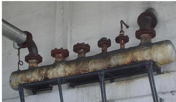
**Figura 4.1** Distribuidor de vapor del área de tintorería
