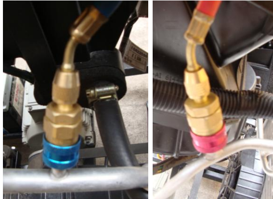
Figura 7.3: Conexión de los acoples a las válvulas de servicio
