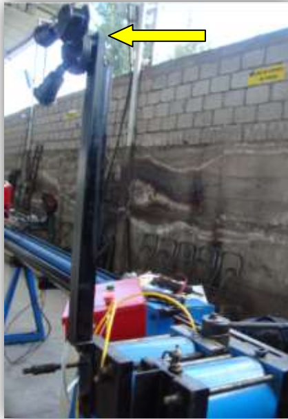
Figura 4.20.- Sensor de seguridad – operador.
