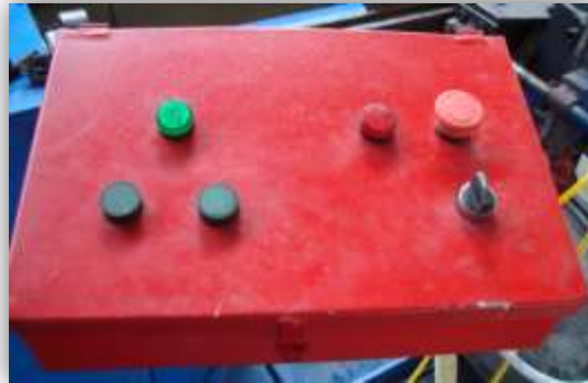
Figura 3.32.- Montaje e instalación del tablero de mando.
