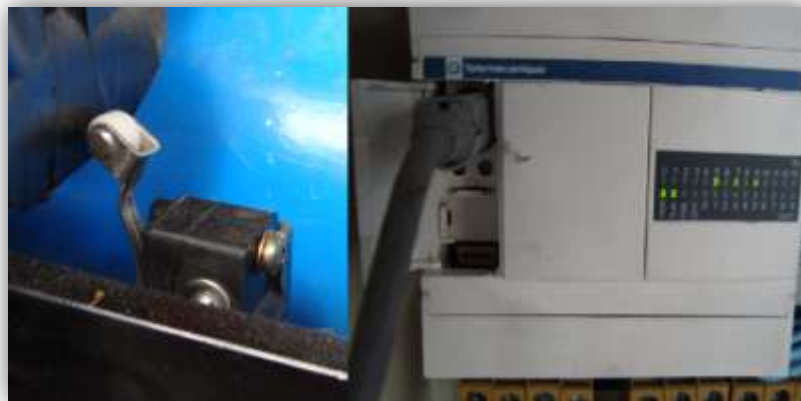
Figura 4.15.- Prueba de sensores.
