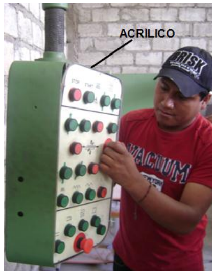
Figura 4.29: Montaje e instalación de pulsadores del panel operador
