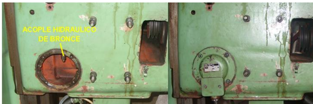
Figura 4.16: Montaje de la bomba hidráulica
