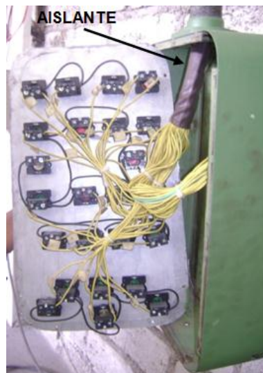
Figura 4.30: Conexionado eléctrico del panel operador al tablero de control
