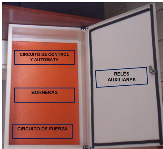
Figura 2.11: Distribución de espacios en el tablero de control
