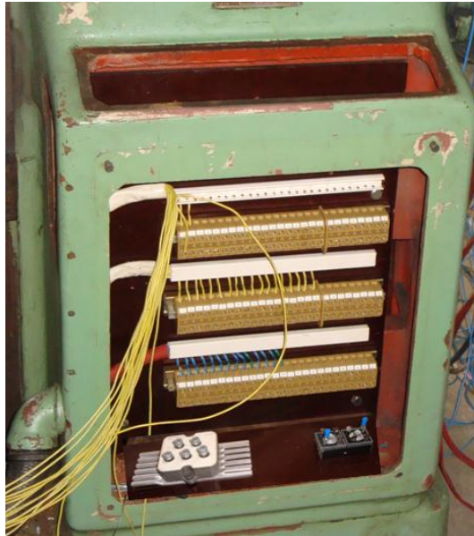
Figura 4.22: Montaje y Conexionado de elementos en el tablero de potencia
