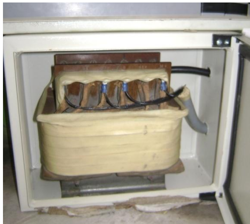
Figura 4.34: Montaje del transformador reductor
