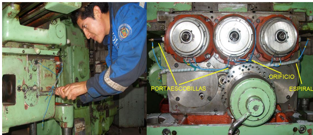
Figura 4.19: Cableado de embragues-frenos electromagnéticos
