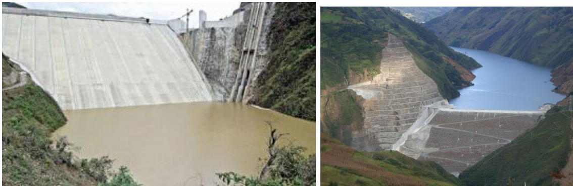
Figura 2 Vista de Pantalla y enrocado de Presa Mazar. (Imágenes de Presa Mazar. Internet).
