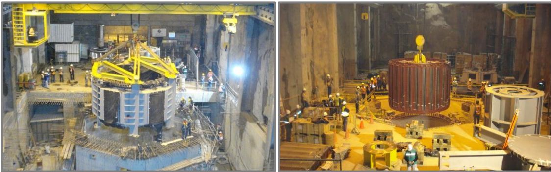
Figura 2.102: a) Bajada del estator de la unidad No.1, b) Bajada del rotor de la unidad
