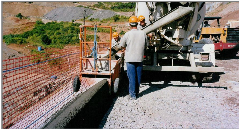
Figura 1.19: Construcción de bordillos - Presa Itá (Fuente: Marengo H., 2010)
