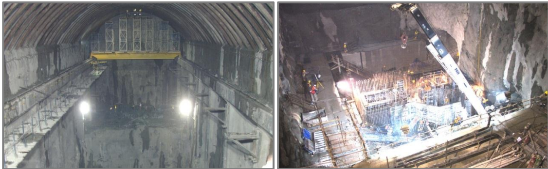
Figura 2.99: a) Puente grúa instalado en casa de máquinas, b) Excavación y hormigonado del área de los difusores (Fuente: Caminosca, 2011)
