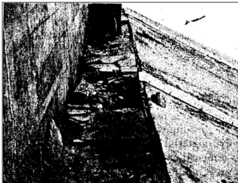
Figura 1.32: Foto de la zona de contacto entre el muro parapeto y la pantalla de hormigón de la presa Gouhou (Fuente: Alonso, Peuser, Bertoni & Menajovsky, 2011)
