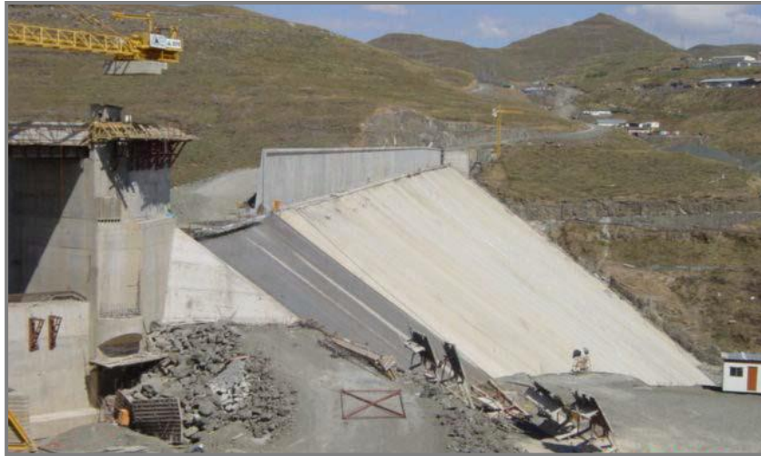
Figura 1.13: Construcción del parapeto (Fuente: Badenhorst D., 2005)
