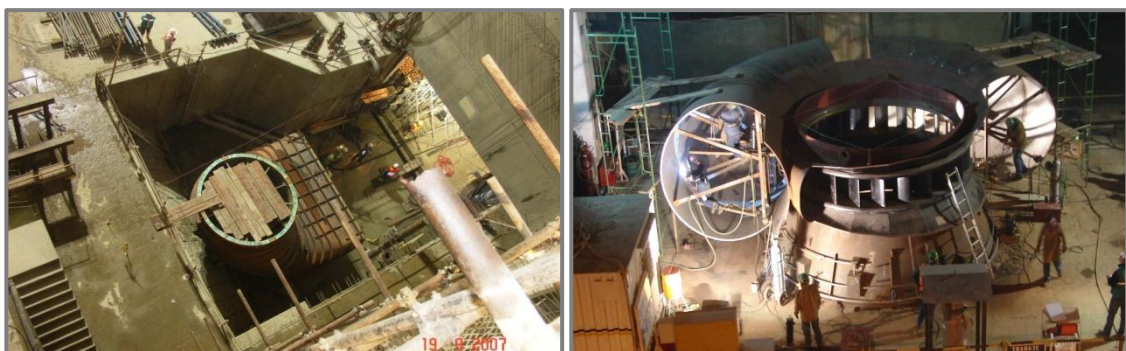
Figura 2.100: a) Colocación del difusor No.1, b) Montaje de la caja espiral in situ (Fuente: Caminosca, 2011)
