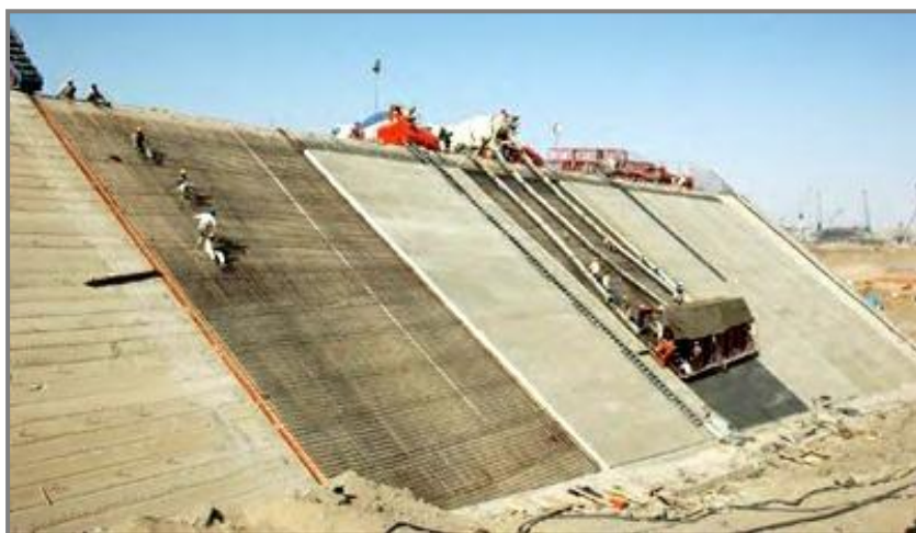
Figura 1.10: Construcción de losas de hormigón en la cara aguas arriba de presas CFRD (Fuente: flickr.com)
