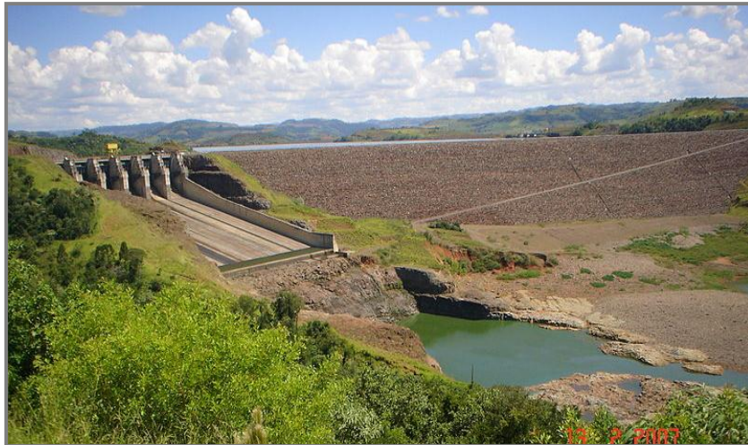
Figura 1.18: Presa Itá (Fuente: en.wikipedia.org)
