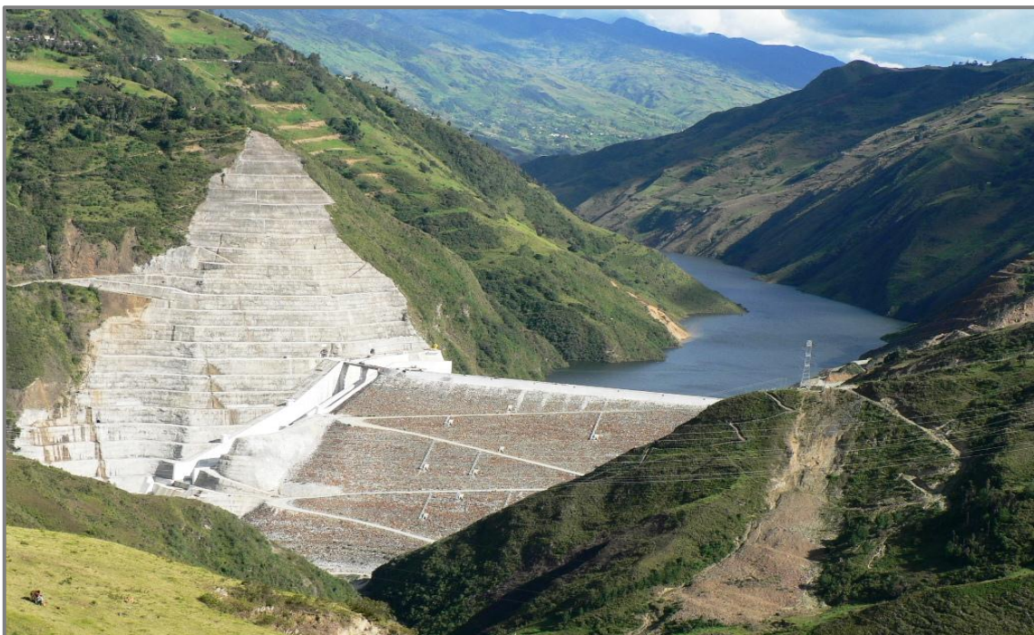
Figura 2.104: Vista general de la presa Mazar (Fuente: Caminosca, 2011)
