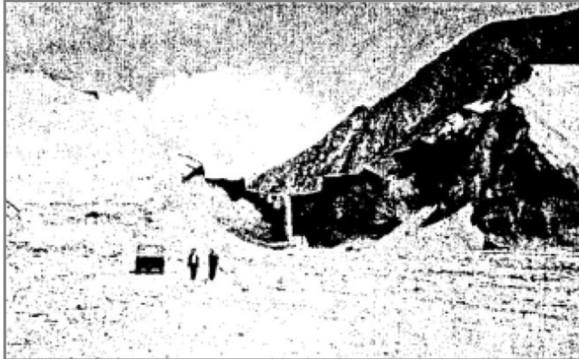
Figura 1.31: Foto desde aguas abajo del estado remanente de la presa Gouhou luego del desastre (Fuente: Alonso, Peuser, Bertoni & Menajovsky, 2011)
