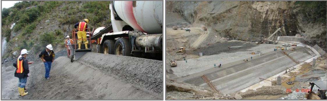
Figura 2.90: a) Fundición del bordillo, b) Construcción de la Presa Mazar
