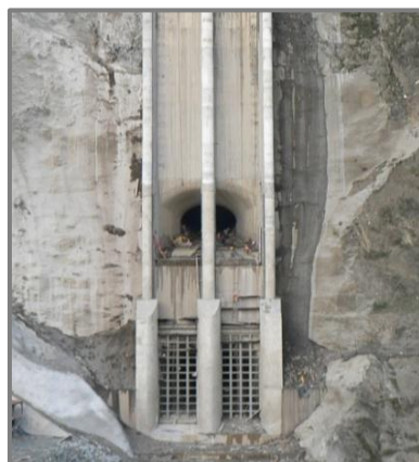
Figura 2.96: Bocatoma túnel de carga y desagüe de fondo (Fuente: Caminosca, 2011)
