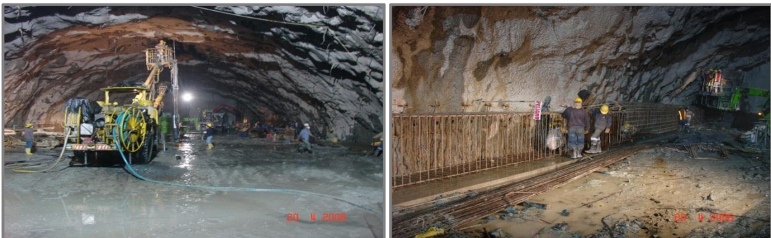
Figura 2.98: a) Excavación casa de máquinas, b) Viga para cerchas de la casa de máquinas (Fuente: Caminosca, 2011)
