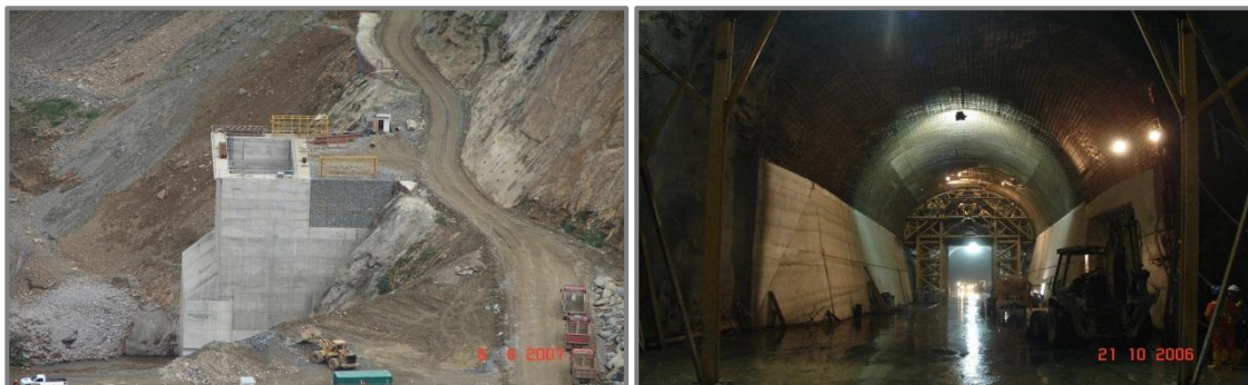
Figura 2.81: a) Estructura de entrada al túnel de desvío, b) Zona revestida del túnel de desvío (Fuente: Caminosca, 2011)
