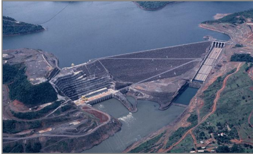
Figura 1.7: Presa Foz do Areira – Brasil (Fuente: chincold.org.cn)
