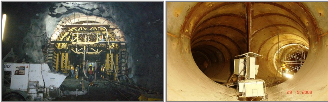
Figura 2.97: a) Revestimiento de hormigón armado del túnel de carga, b) Bifurcación de la tubería de presión (Fuente: Caminosca, 2011)
