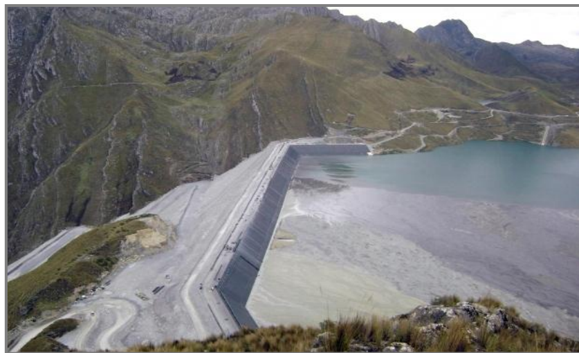
Figura 1.15: Presa de relaves de Antamina (Fuente: golder.com)
