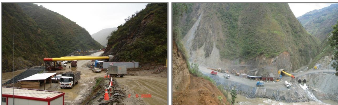
Figura 2.80: a) Ventana de construcción del túnel de desvío, b) Encauce del río Mazar y salida túnel de desvío (Fuente: Caminosca, 2011)
