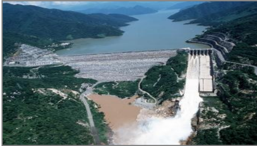
Figura 1.14: Presa Aguamilpa (Fuente: comunicacion.promexico.gob.mx)
