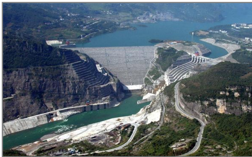
Figura 1.21: Presa Shuibuya (Fuente: hydropower.org)
