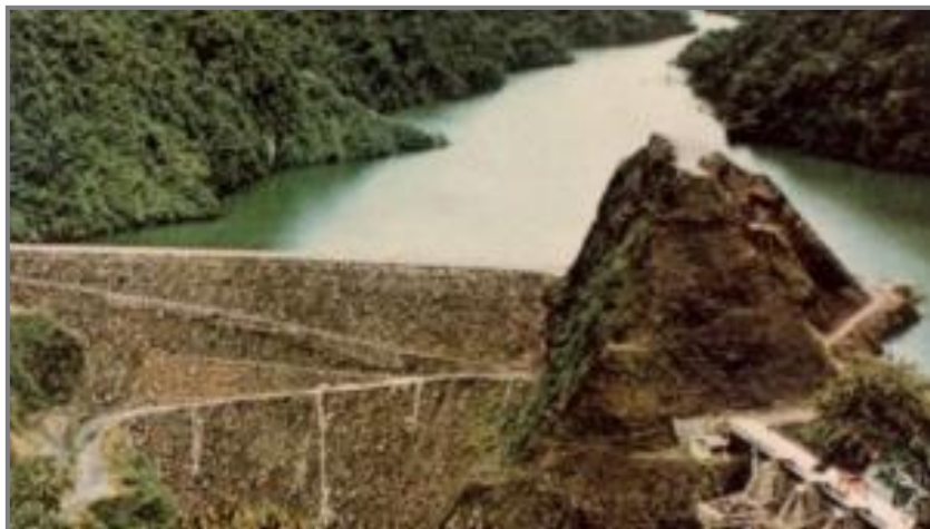
Figura 1.17: Presa Alto Anchicayá (Fuente: infraestructura.ingenet.com.mx )
