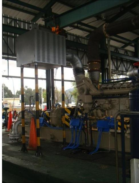
FIGURA 5.19 Pintura de las líneas eléctricas, de aceite, y de agua.
