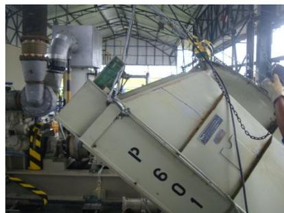
FIGURA 5. 20 Desmontaje del Antigo Radiador
