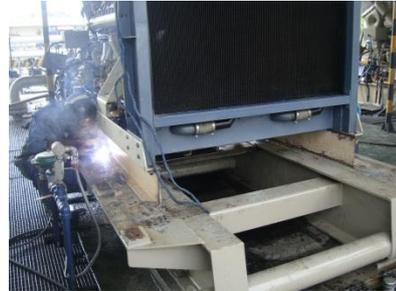
FIGURA 5.23 Proceso de Soldadura de perfiles UPN al patín.
