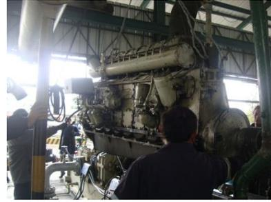
FIGURA 5.12 Desmontaje del Motor
