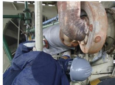
FIGURA 3.115 Inspeccionando el mofle de escape.
