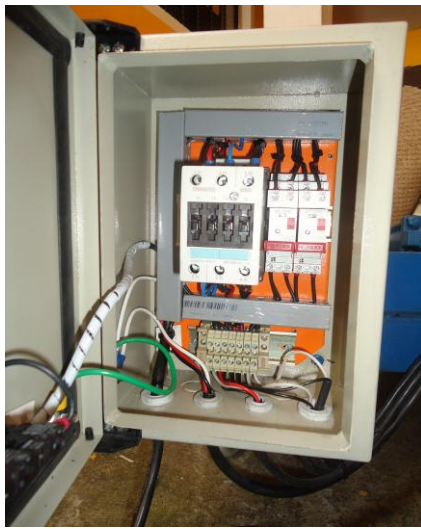
Figura 4.28: Armado de los elementos eléctricos
