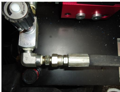
Figura 4.26: Acoplamiento de las mangueras hidráulicas
