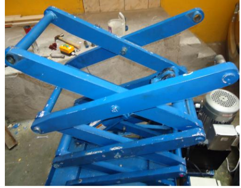
Figura 4.23: Montaje del tercer segmento de tijeras
