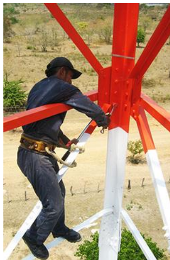
Figura 2.14 Proceso de mantenimiento de pernos 22
