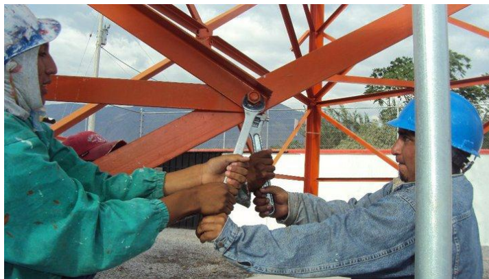
Figura 5.2 Desensamble manual en torre 100
