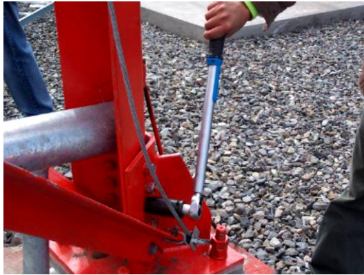
Figura 2.22 Apriete con llave manual en bases de torres de 24 metros de altura 33
