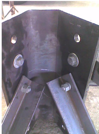
Figura 5.3 Ensamble manual en placas 101
