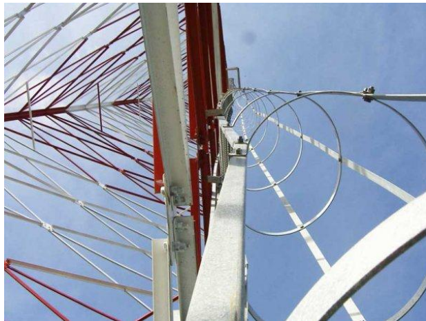
Figura 2.2 Guardacuerpos sobre la escalera de una torre de 102 metros de altura 8
