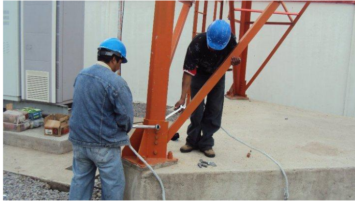
Figura 5.1 Ensamble manual en torre 99
