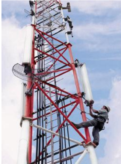
Figura 2.15 Proceso de mantenimiento de antenas 23
