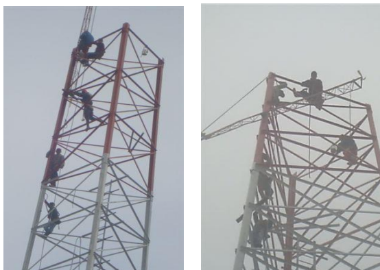
Figura 1.3 Proceso de montaje de una torre de 24 m de altura 3
