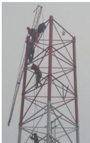
Figura 2.10 Personal de montaje colocando la pluma 18
