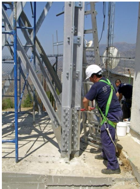
Figura 1.2 Proceso de ensamble manual de una torre 2
