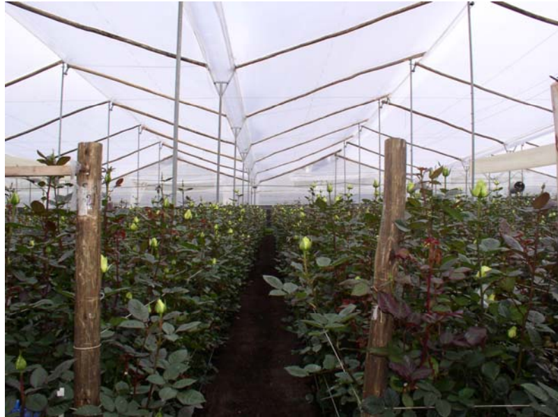
Figura 2.4 Invernadero tipo capilla
