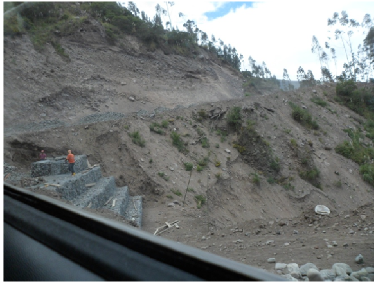
Figura. 3. 4 Amenaza a Deslizamiento, Construcción de Terrazas.
