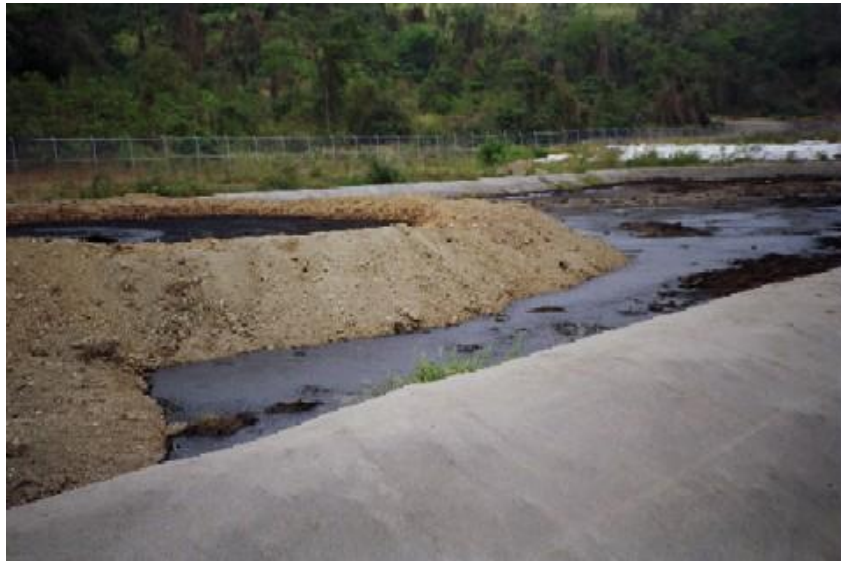
Figura 3.7. Piscina de landfarming utilizada en la REE.
