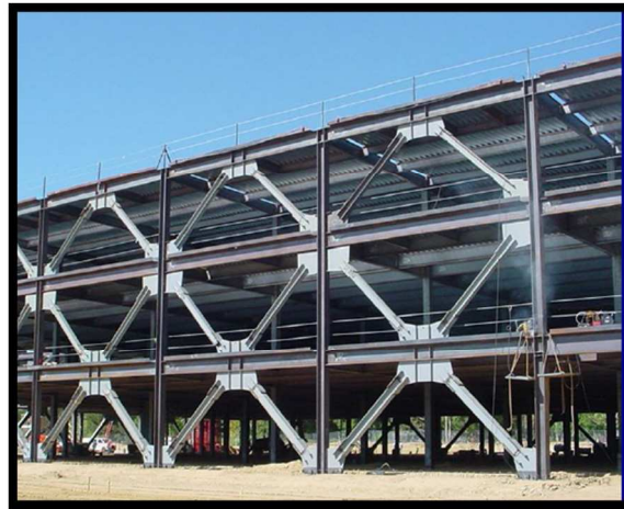
Figura 2.21. Pórticos arriostrados concéntricamente
