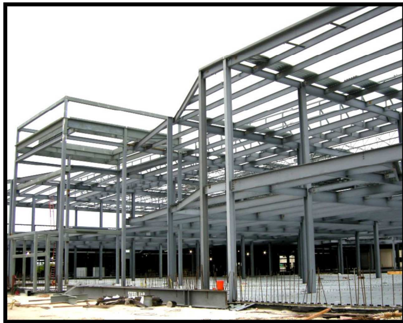
Figura 2.1. Estructura de pórticos no arriostrados
