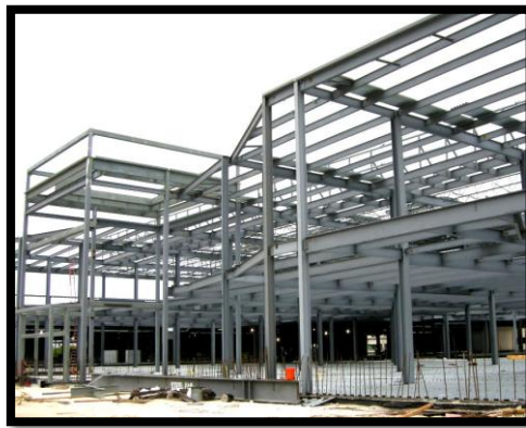
Figura 1. Estructura de pórticos no arriostrados
