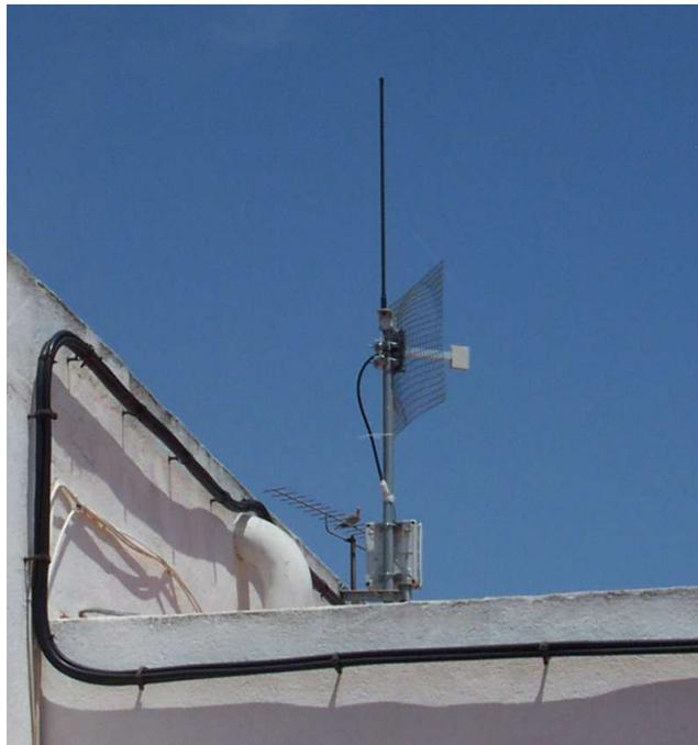
Figura. 5.13. Foto de un tipo de Antena Omnidireccional
