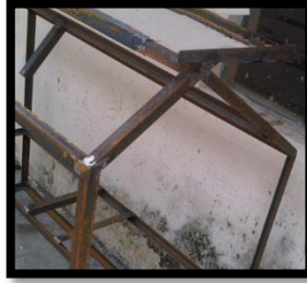
Figura 5.9. Soldadura de los perfiles que servirán como mesa Fuente: Los Autores
