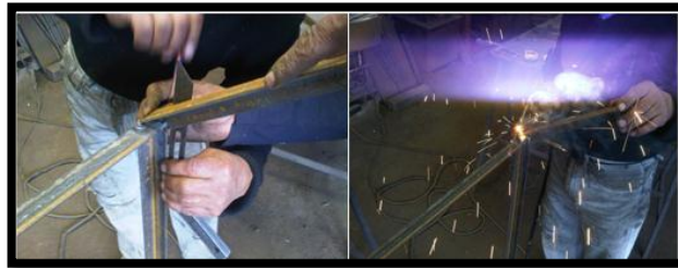
Figura 5.7. Soldadura de los perfiles del tablero de control Fuente: Los Autores
