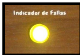
Indicador de fallas Fuente: Los Autores
