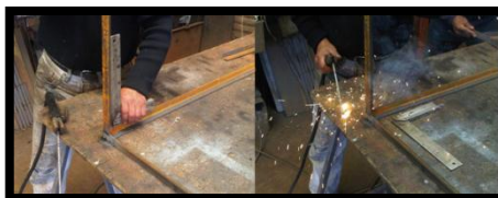
Figura 5.5. Soldadura de los parantes de la estructura Fuente: Los Autores
