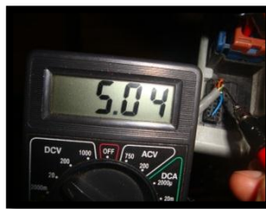
Figura 6.6. Comprobación de Falla C1112
