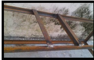
Figura 5.16. Soldadura de los soportes de la caja de dirección Fuente: Los Autores
