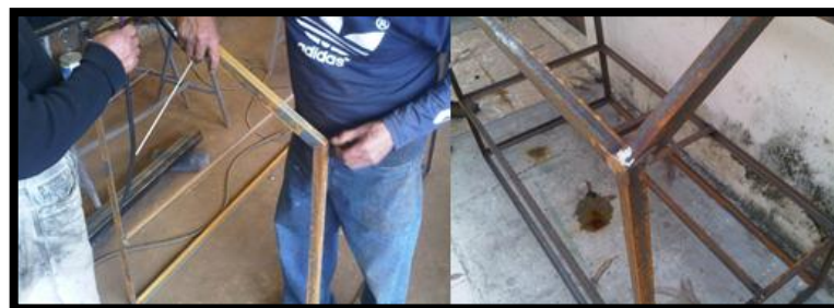
Figura 5.8. Soldadura de los perfiles inclinados posteriores Fuente: Los Autores
