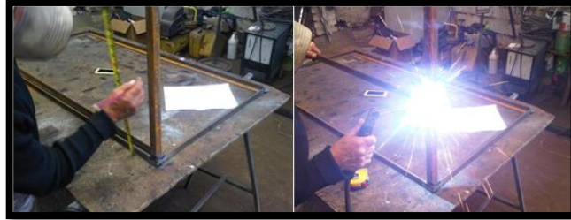
Figura 5.6. Soldadura de los perfiles transversales Fuente: Los Autores
