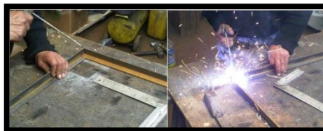
Figura 5.4. Soldadura de los perfiles de base Fuente: Los Autores
