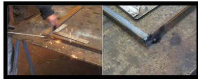
Figura 5.3. Soldadura de los perfiles Fuente: Los Autores
