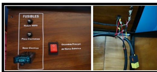
Figura 5.39. Montaje de fusibles Fuente: Los Autores
